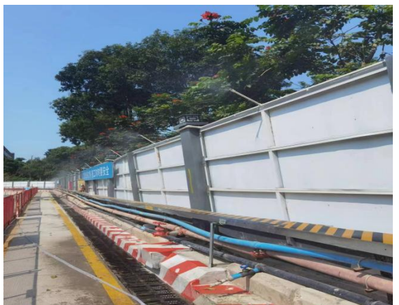
基坑顶部排水沟运行情况
