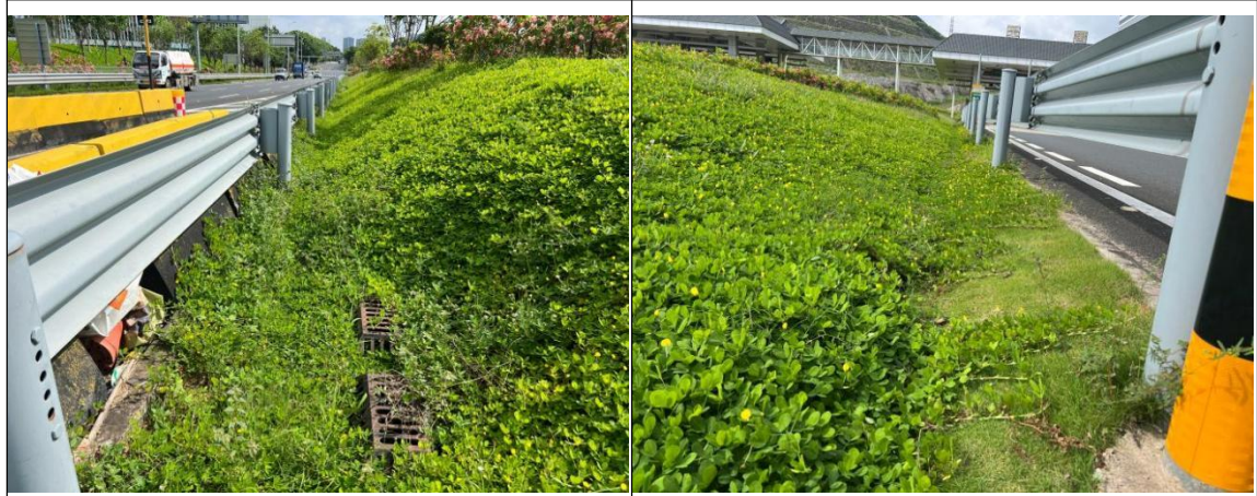
生态草沟与边坡防护现状
