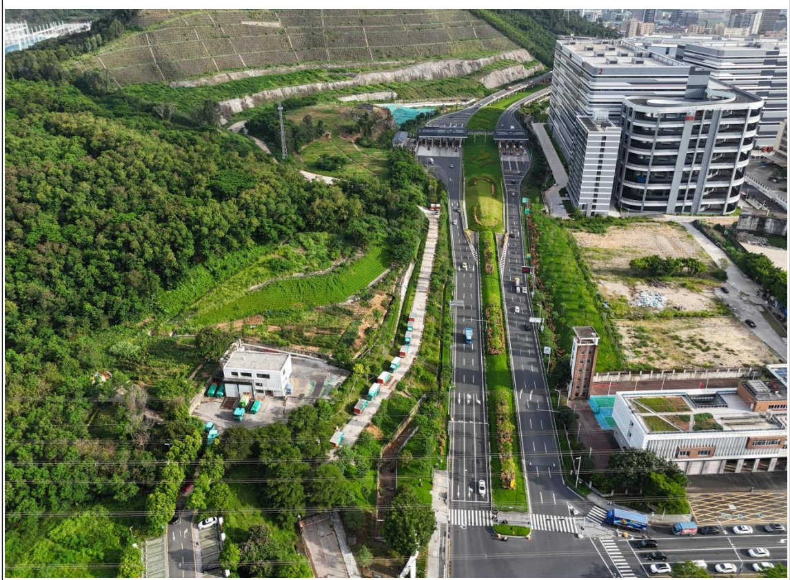
航拍全景现状（外环高速松岗南出入口周边环境整治工程）
