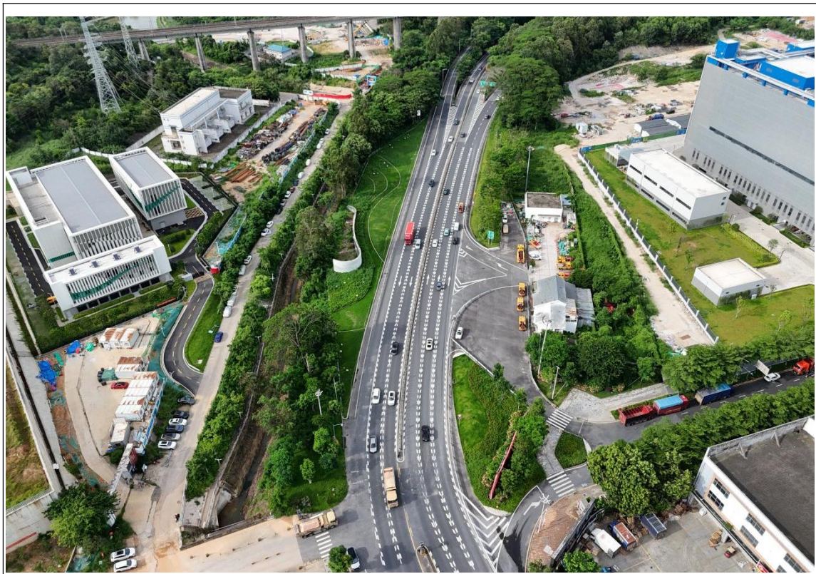
航拍全景现状（宝安区龙大高速罗田（燕罗）出入口周边环境整治工程）
