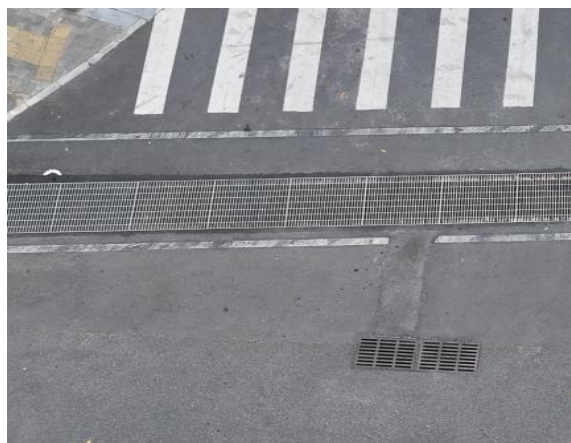
雨水管线的雨水口与盖板边沟现状
