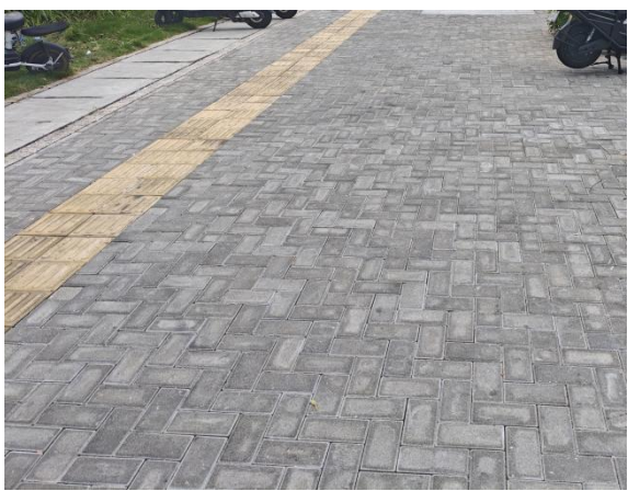
透水铺装现状
