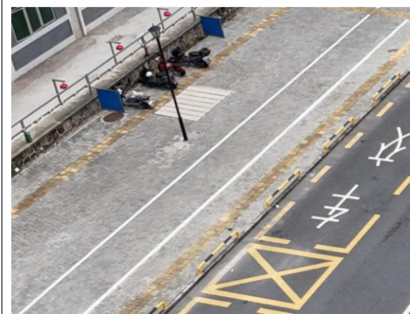
透水铺装现状
