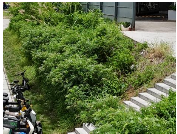
三维网植草护坡现状
