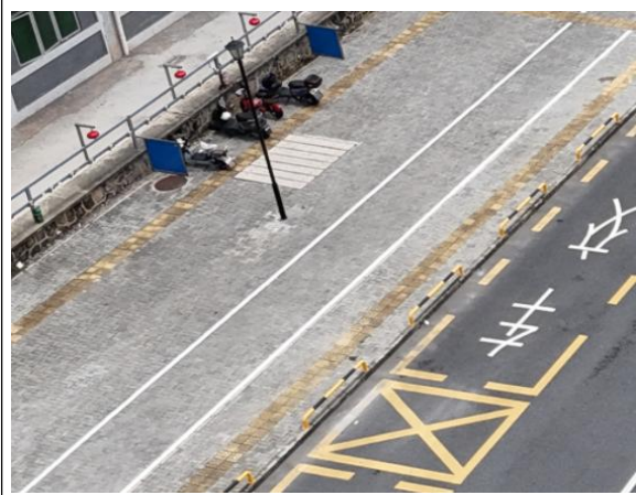
透水铺装现状
