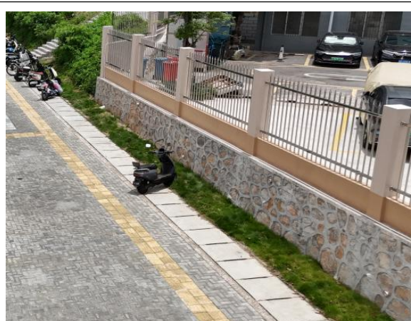
盖板边沟、透水铺装与绿化工程现状
