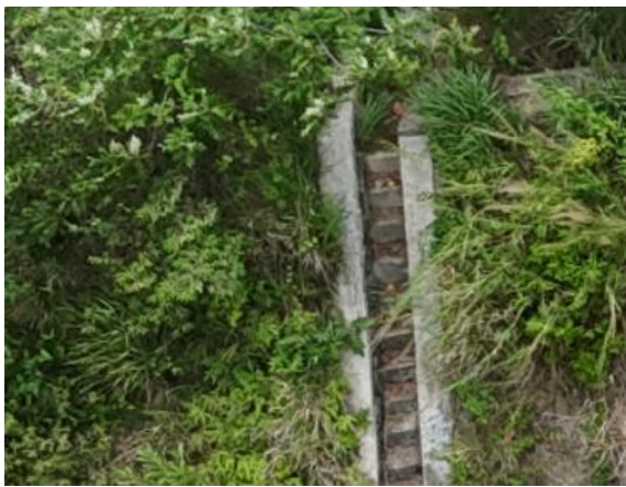
急流槽与边坡覆绿现状
