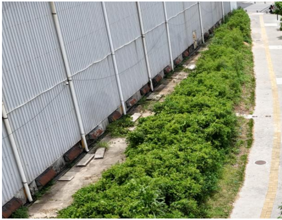
透水铺装与三维网植草护坡现状
