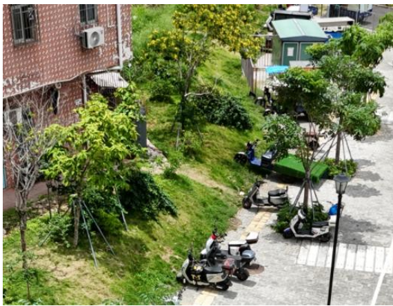
三维网植草护坡现状
