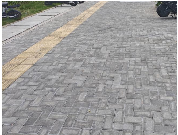
透水铺装现状
