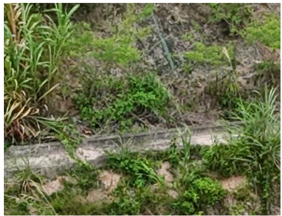
截水沟与边坡覆绿现状
