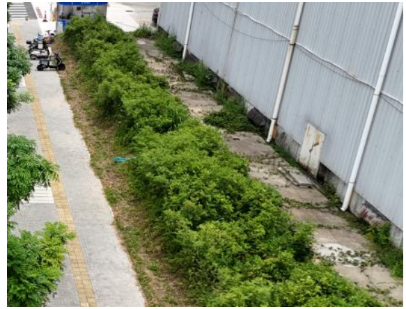
透水铺装与三维网植草护坡现状
