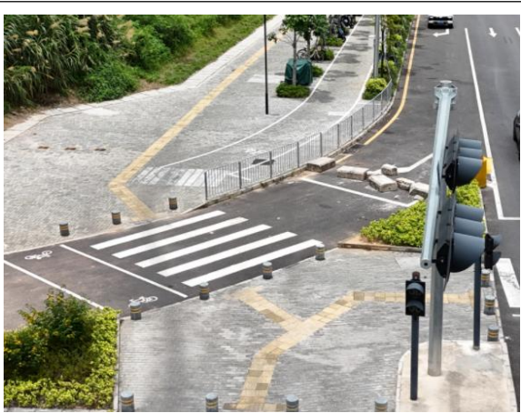
透水铺装现状
