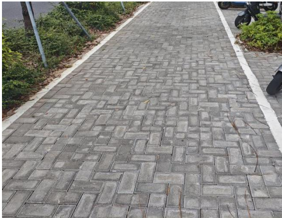
透水铺装现状
