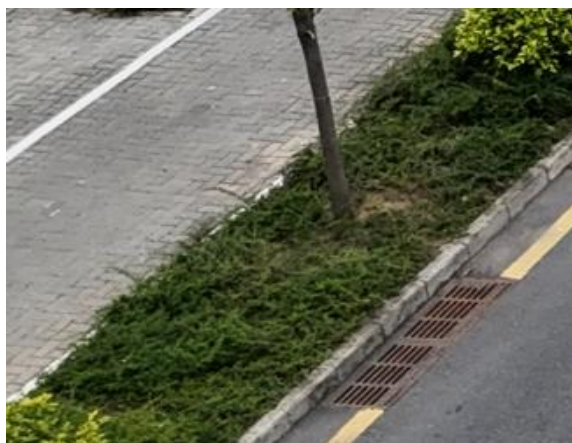
雨水管线的雨水口、透水铺装与绿化工程现状
