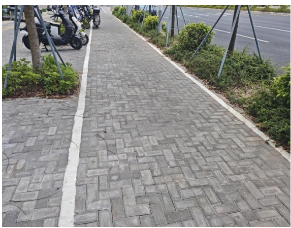
透水铺装现状
