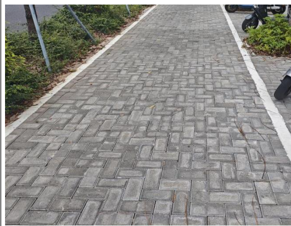
透水铺装现状
