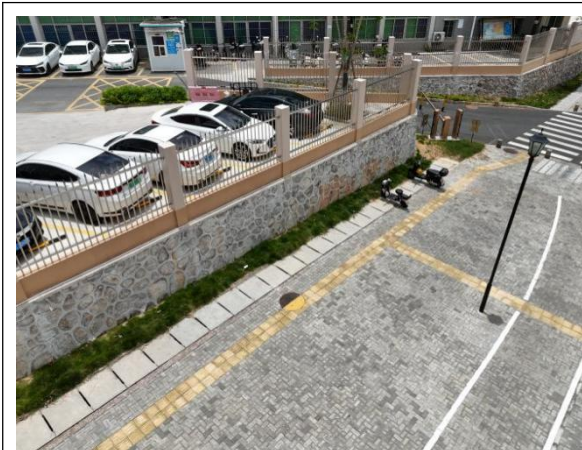
盖板边沟、透水铺装与绿化工程现状
