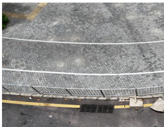
雨水管线的雨水口与透水铺装现状
