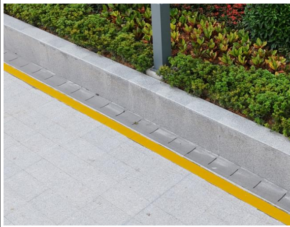
盖板排水沟现状
