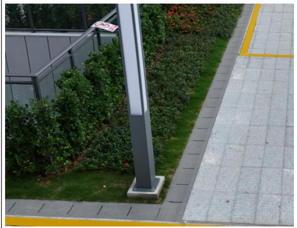
盖板排水沟现状
