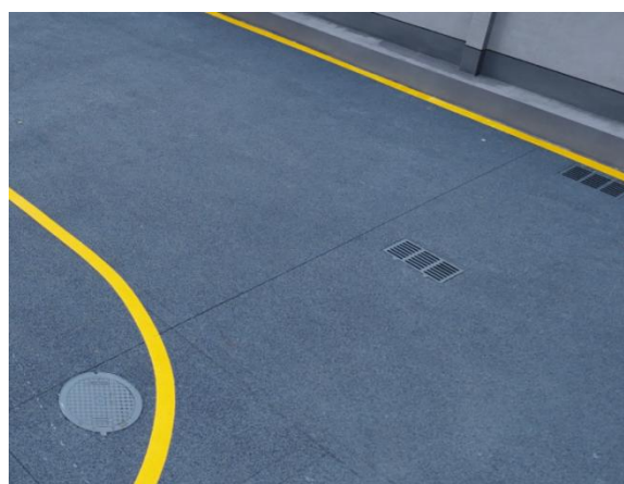
透水铺装与雨水管线的雨水口现状
