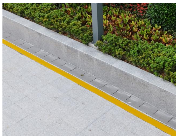
盖板排水沟与园林绿化现状
