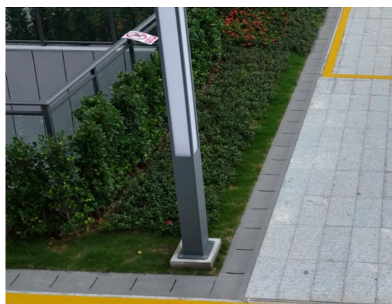
盖板排水沟与园林绿化现状
