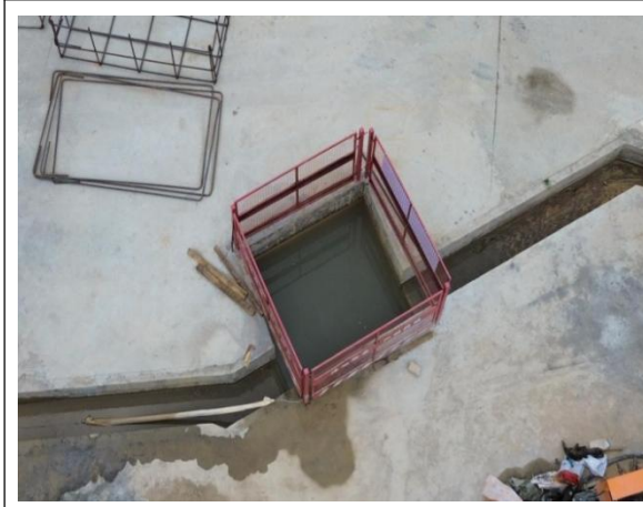
单级沉沙池与基坑顶部排水沟运行情况
