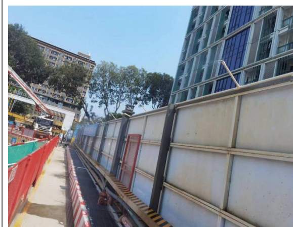
施工围挡与基坑顶部排水沟运行情况
