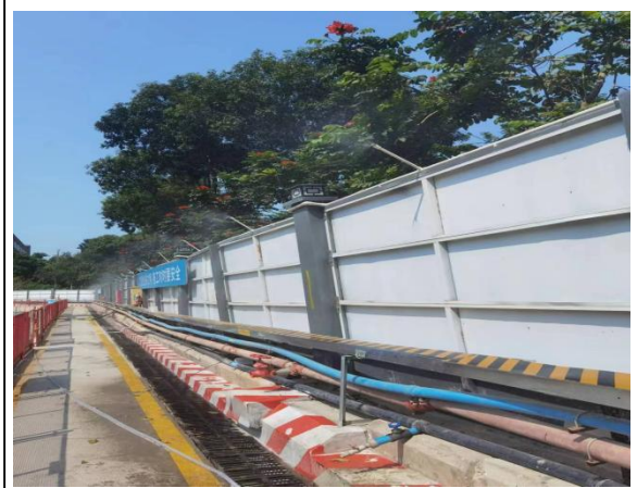
基坑顶部排水沟运行情况
