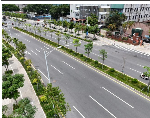
绿化工程现状
