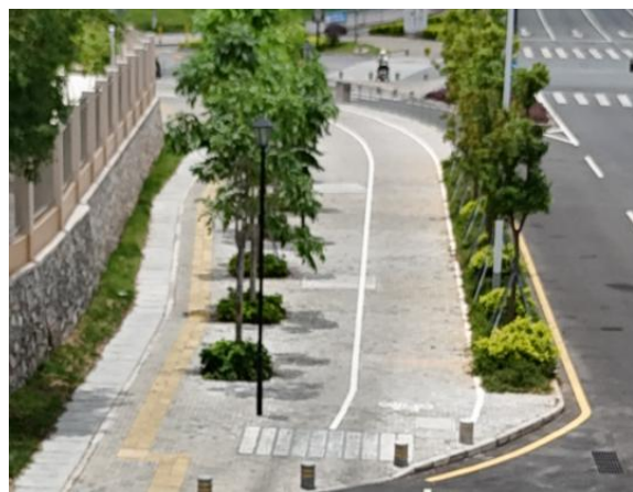
透水铺装与绿化工程现状
