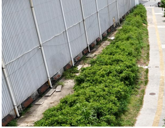
透水铺装与三维网植草护坡现状
