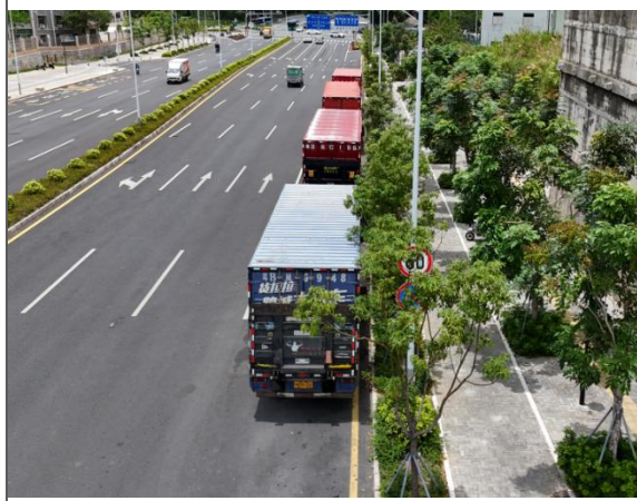
绿化工程现状
