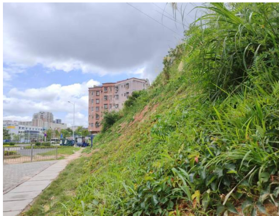
边坡覆绿现状
