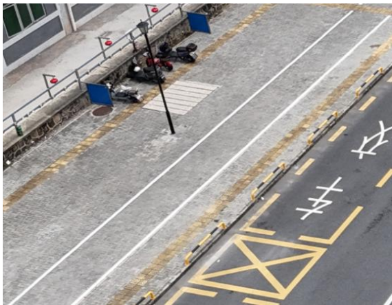
透水铺装现状
