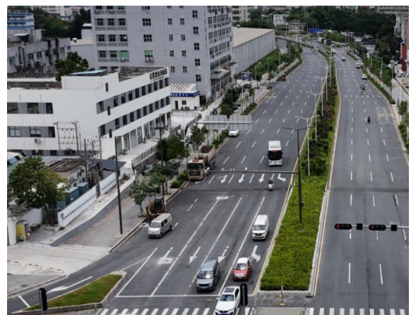
绿化工程现状
