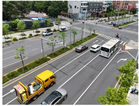
绿化工程现状
