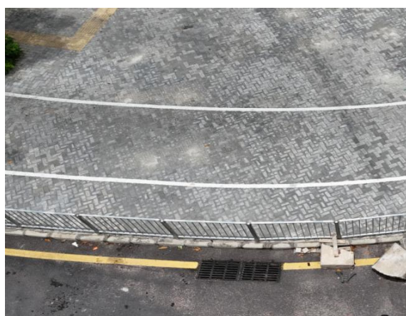
雨水管线的雨水口与透水铺装现状
