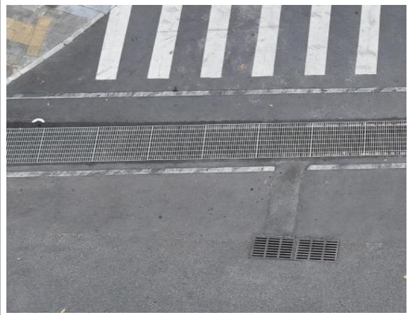
雨水管线的雨水口与盖板边沟现状
