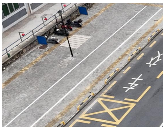
透水铺装现状
