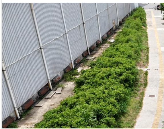
三维网植草护坡现状
