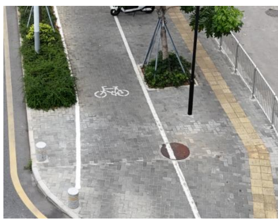
透水铺装现状
