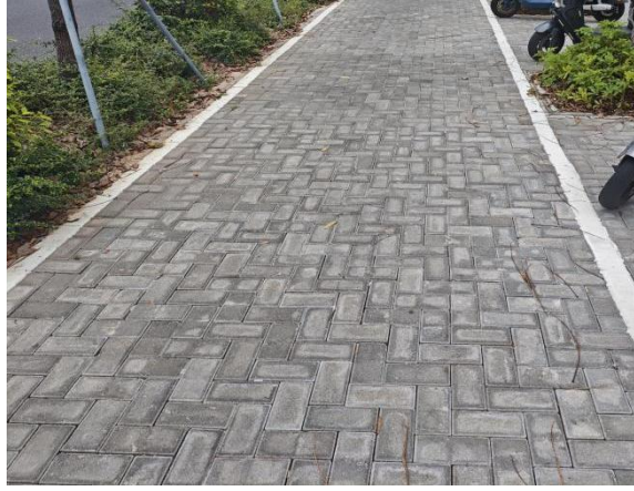
透水铺装现状
