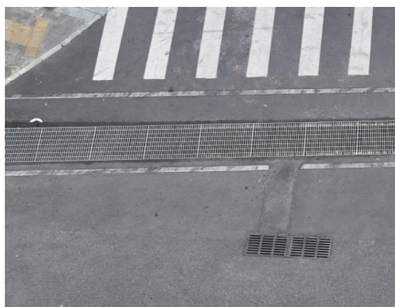
雨水管线的雨水口与盖板边沟现状
