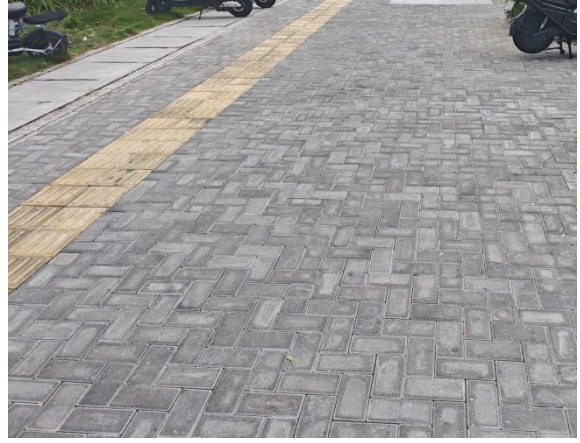
透水铺装现状
