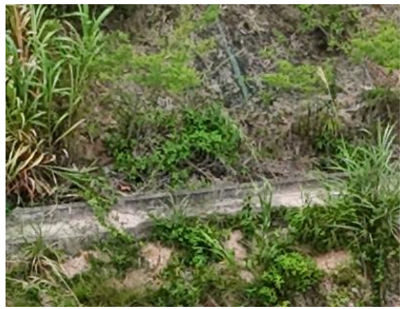
截水沟与边坡覆绿现状
