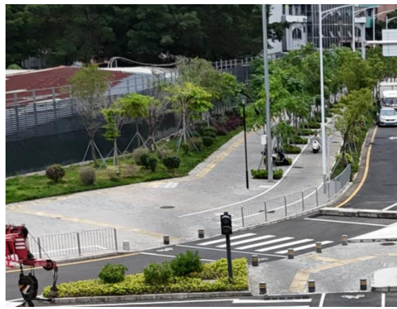
透水铺装与绿化工程现状
