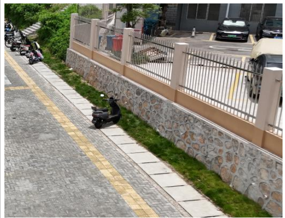
盖板边沟与透水铺装现状
