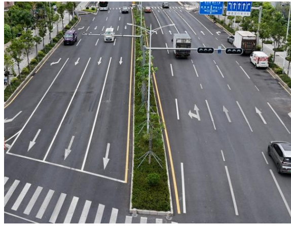
绿化工程现状
