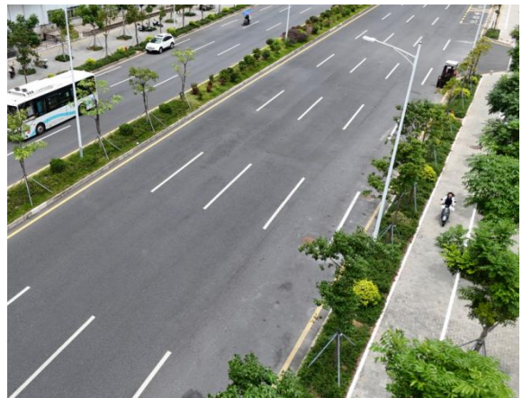
绿化工程现状
