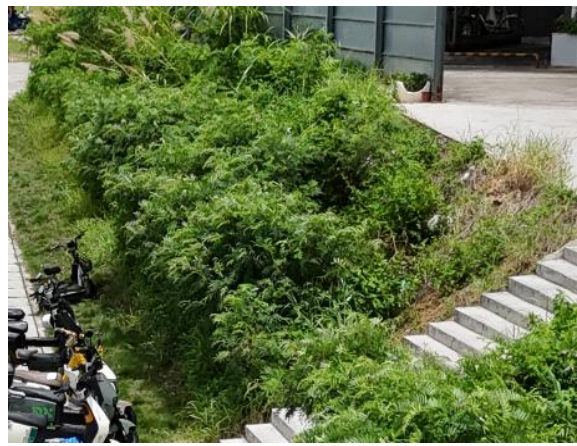
三维网植草护坡现状
