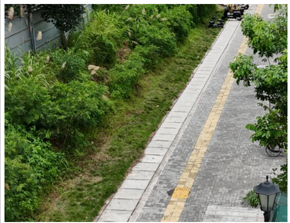
盖板边沟与透水铺装现状
