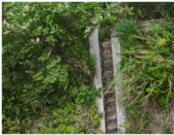
急流槽与边坡覆绿现状
