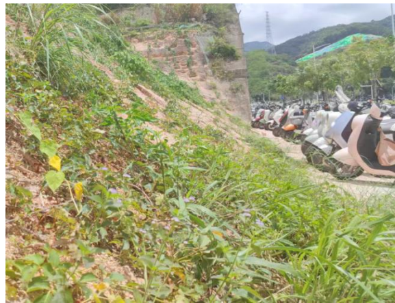
边坡覆绿现状
