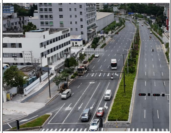
绿化工程现状
