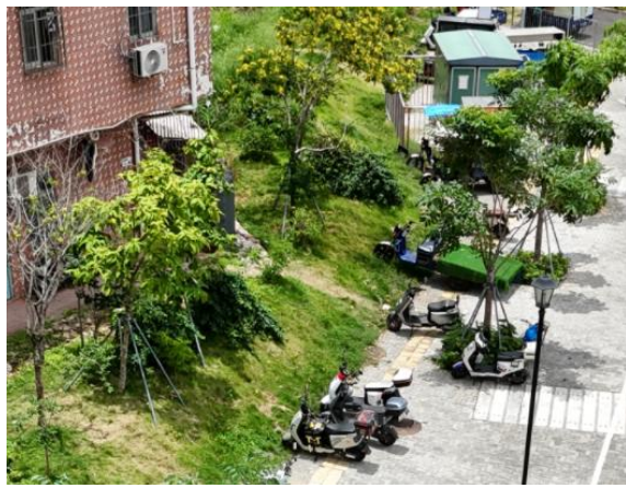
三维网植草护坡现状
