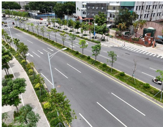
绿化工程现状
