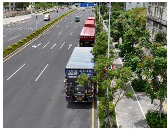
绿化工程现状
