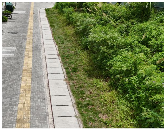
盖板边沟与透水铺装现状
