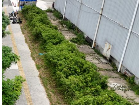
透水铺装与三维网植草护坡现状
