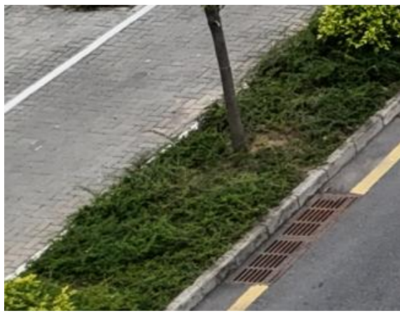
雨水管线的雨水口与透水铺装现状
