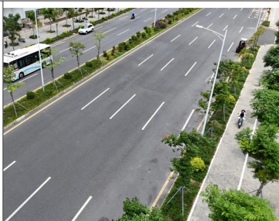
绿化工程现状
