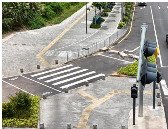
透水铺装与绿化工程现状
