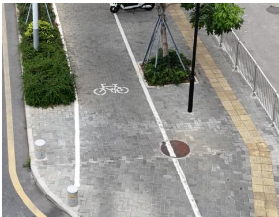
透水铺装与绿化工程现状
