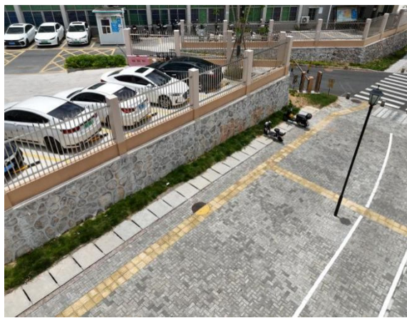
盖板边沟与透水铺装现状
