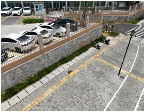
盖板边沟、透水铺装与绿化工程现状
