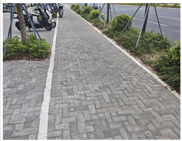
透水铺装现状
