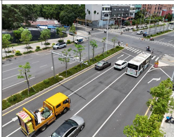
绿化工程现状
