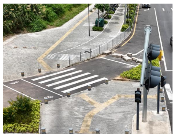
透水铺装现状
