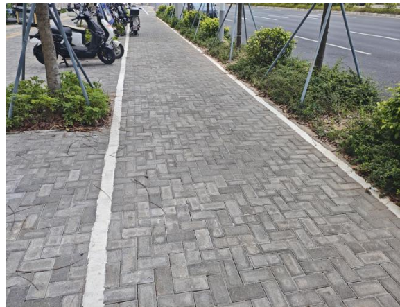
透水铺装与绿化工程现状
