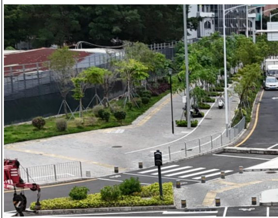
绿化工程现状
