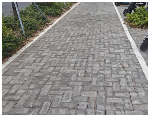
透水铺装现状
