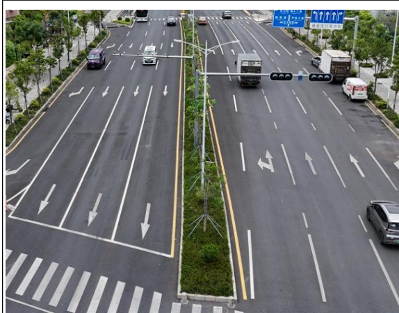
绿化工程现状
