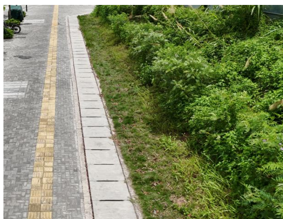
盖板边沟、透水铺装与三维网植草护坡现状
