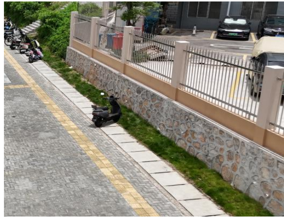
盖板边沟、透水铺装与绿化工程现状
