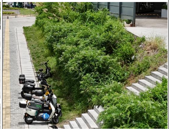
三维网植草护坡现状
