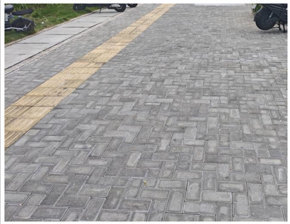
透水铺装现状
