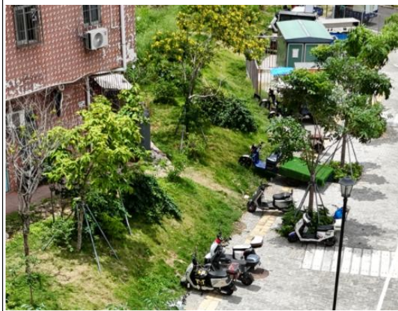
三维网植草护坡现状
