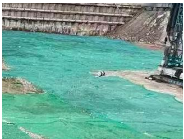
临时覆盖防护情况
