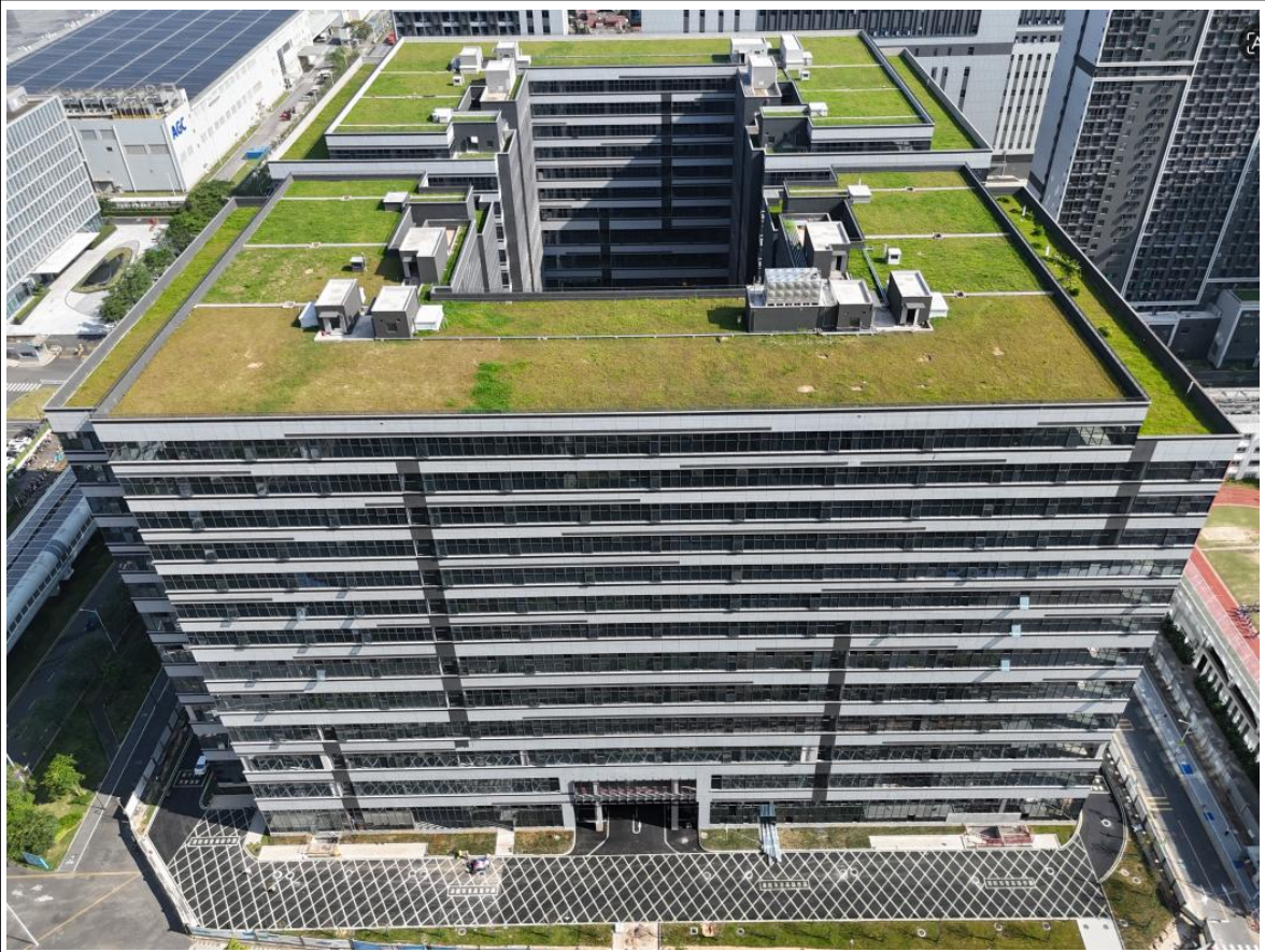
航拍全景现状（02 地块）
