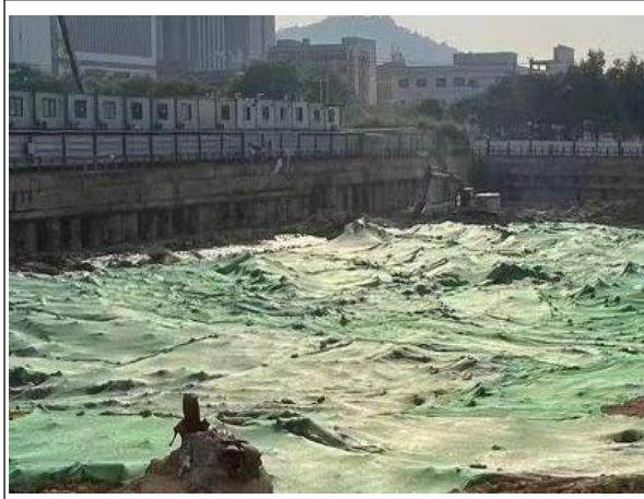
临时覆盖防护情况
