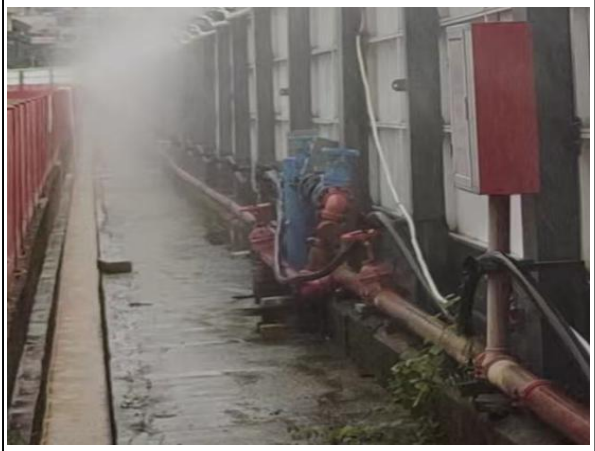
施工围挡与基坑顶部排水沟运行情况
