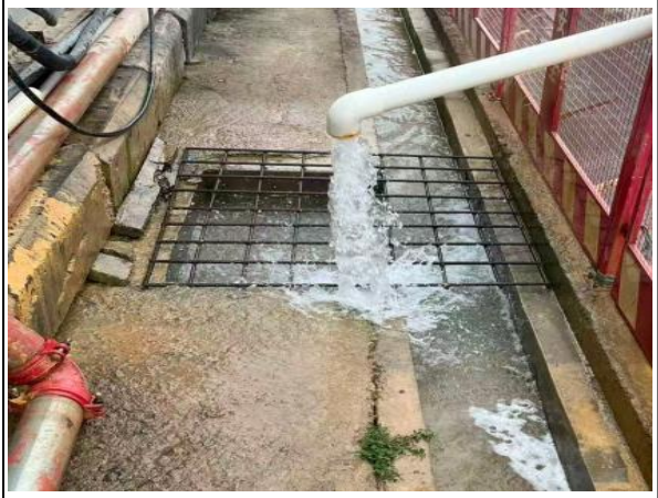
基坑顶部排水沟与单级沉沙池运行情况
