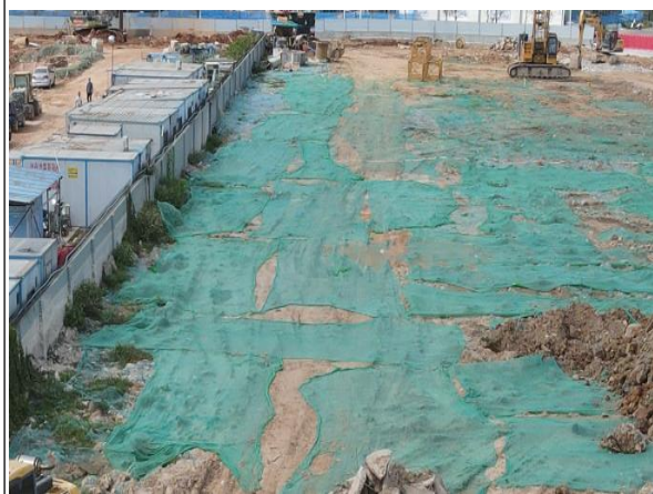
临时覆盖防护情况
