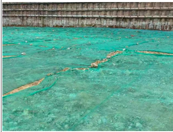
临时覆盖防护情况
