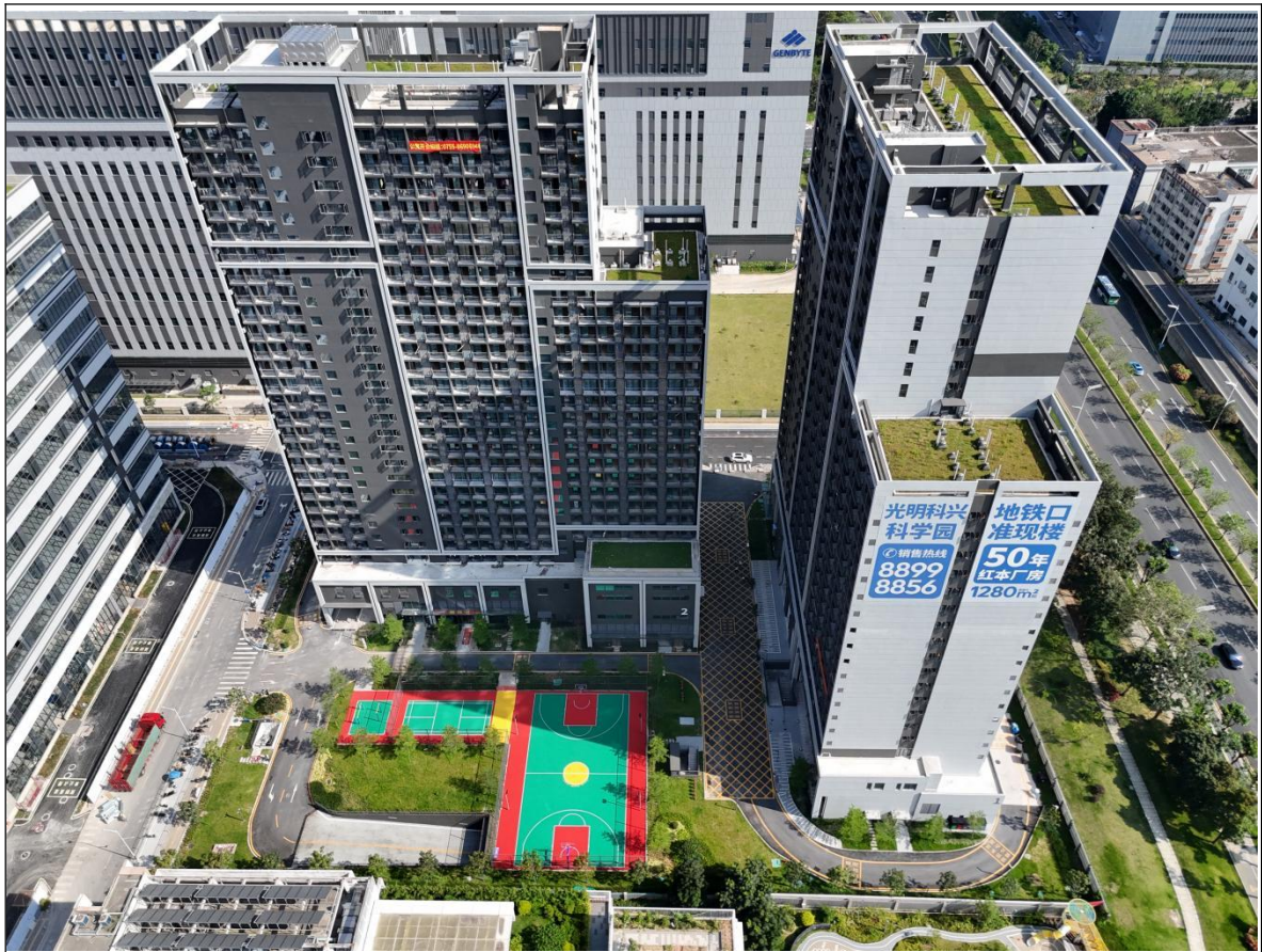
航拍全景现状（01 地块）
