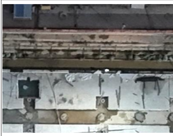
基坑底部排水沟运行情况
