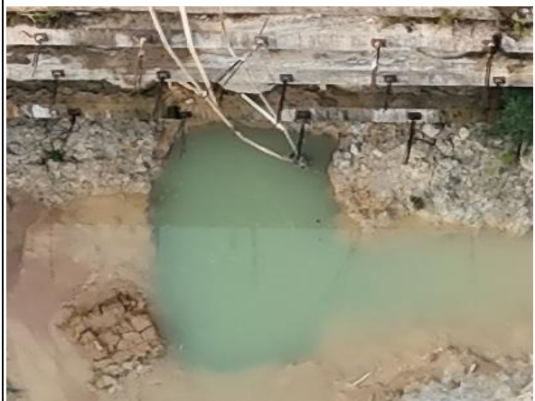
动态集水井运行情况
