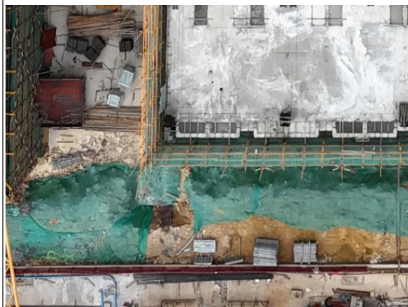
临时覆盖防护情况
