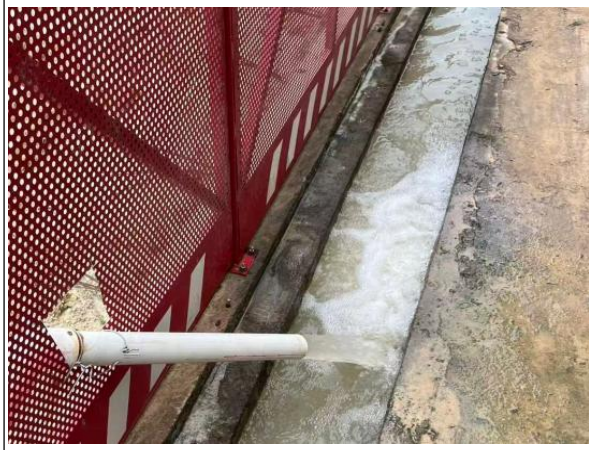
基坑顶部排水沟运行情况
