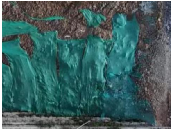
临时覆盖防护情况
