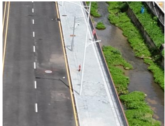
透水铺装现状
