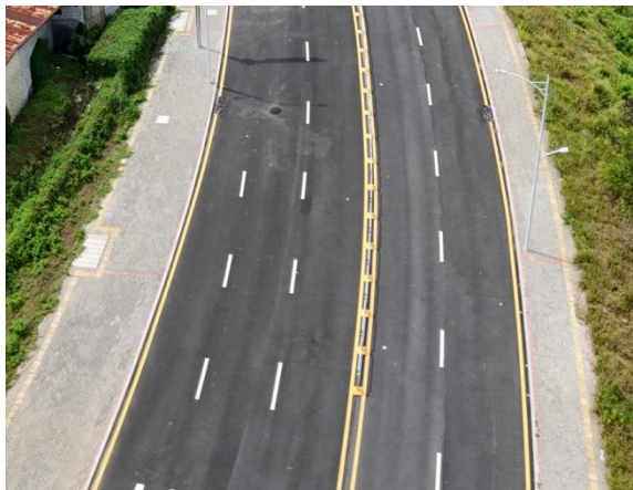
透水铺装现状
