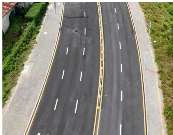
透水铺装现状
