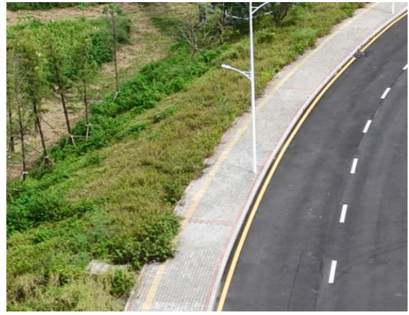
喷播植草防护现状
