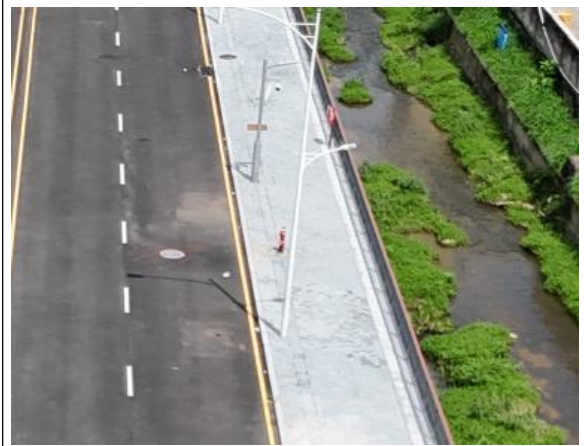
透水铺装现状
