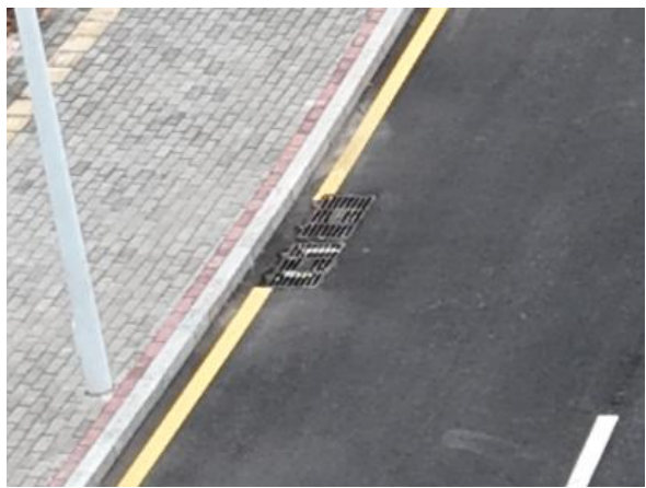
雨水管网的雨水口与透水铺装现状
