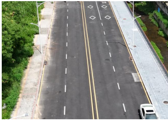
透水铺装现状
