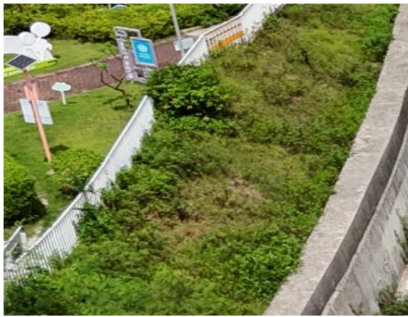
喷播植草防护现状
