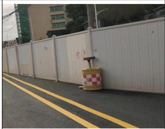
施工围挡运行情况
