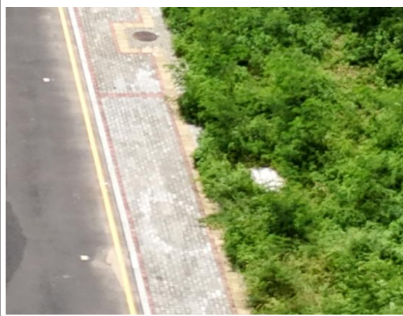
透水铺装现状
