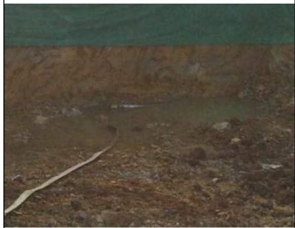
临时沉沙池运行情况
