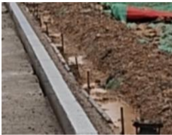
临时排水沟运行情况
