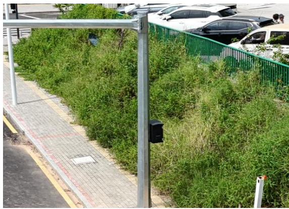
透水铺装现状
