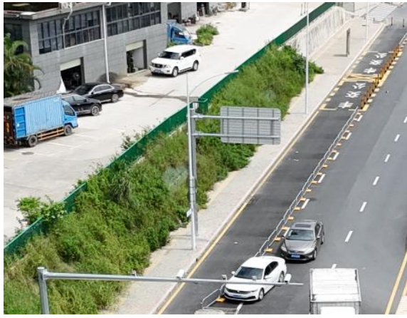
喷播植草防护现状
