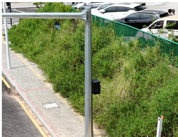
喷播植草防护现状
