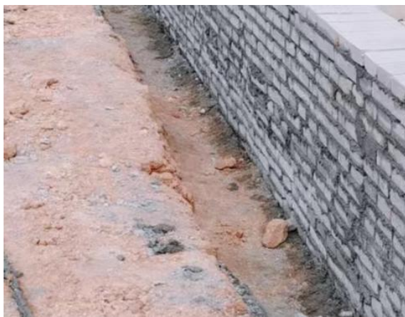
临时排水沟运行情况
