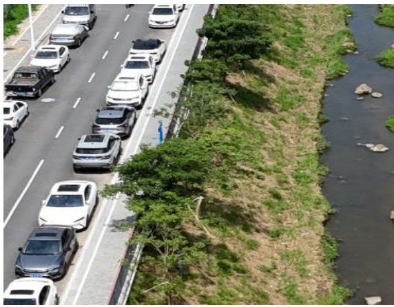
喷播植草防护现状
