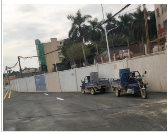
施工围挡运行情况
