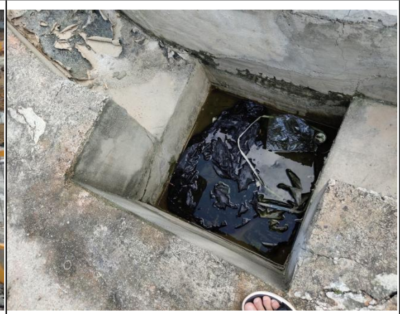
砖砌沉沙池运行情况
