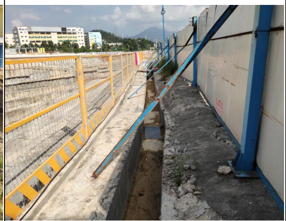
施工围挡与砖砌排水沟运行情况
