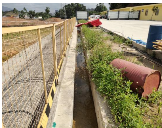
砖砌排水沟运行情况
