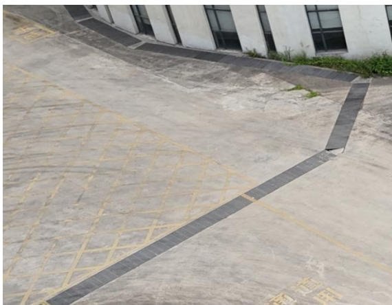
盖板排水沟现状
