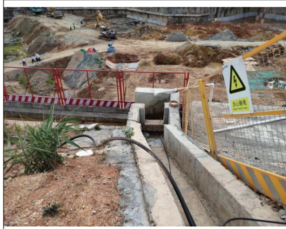
砖砌排水沟与砖砌沉沙池运行情况
