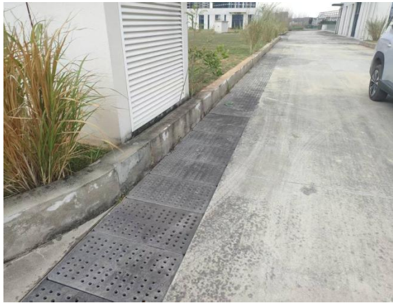
盖板排水沟现状
