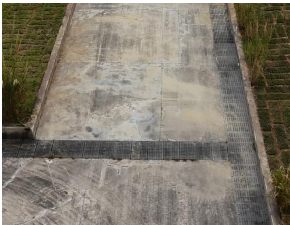
盖板排水沟现状
