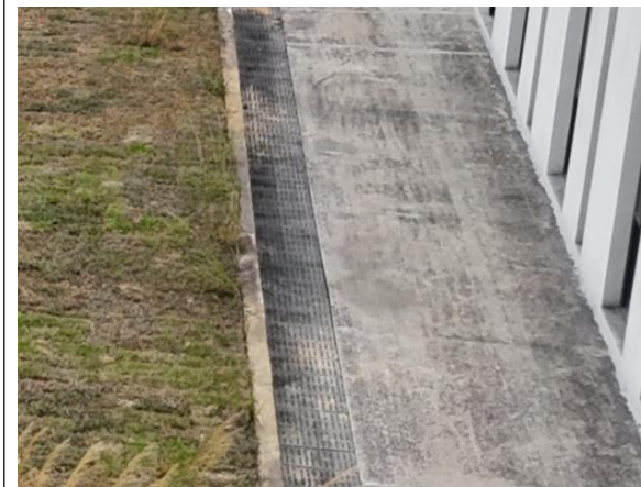
盖板排水沟现状
