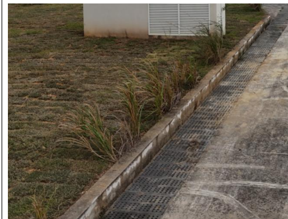
盖板排水沟现状
