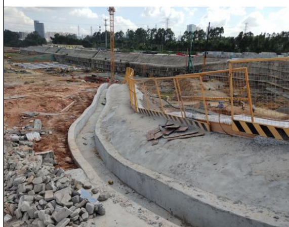
砖砌排水沟运行情况
