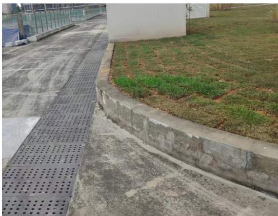
盖板排水沟现状
