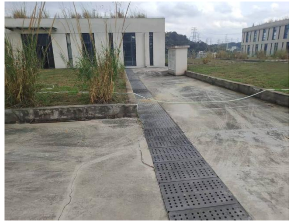
盖板排水沟现状
