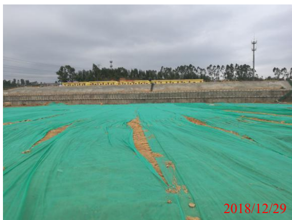
临时覆盖现状 1
