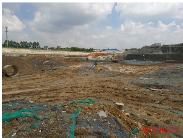
第一标段主体施工进展现状 1
