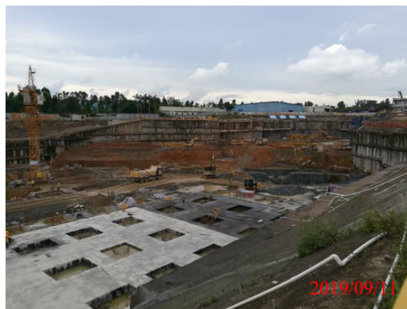
第一标段主体施工进展现状 2
