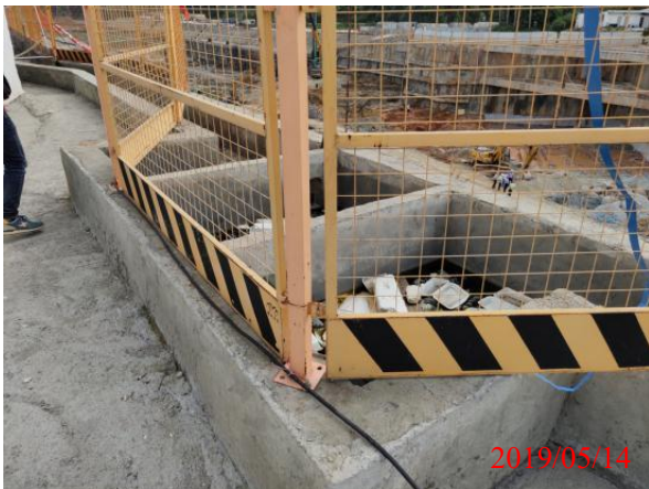
三级沉沙池现状 1
