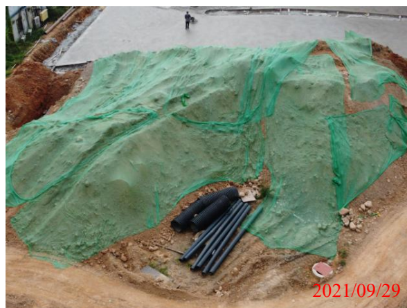
临时覆盖现状 2
