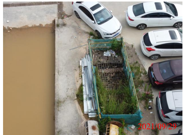
三级沉沙池现状 2
