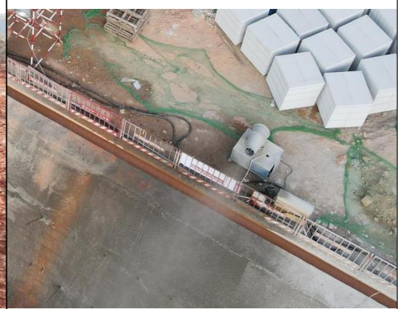
基坑顶部排水沟运行情况
