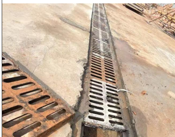
临时排水沟运行情况
