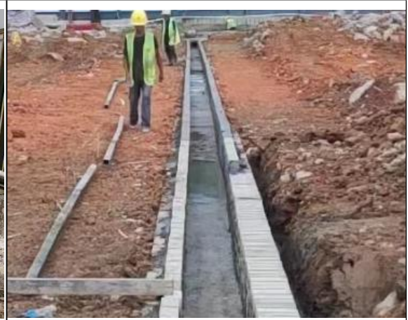
基坑顶部排水沟运行情况
