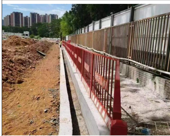
基坑顶部排水沟运行情况
