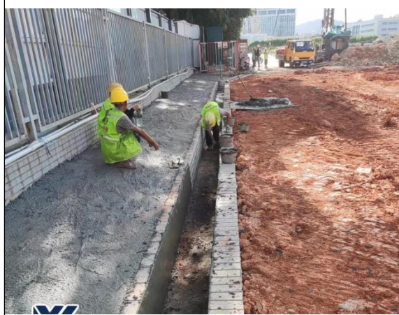
基坑顶部排水沟运行情况
