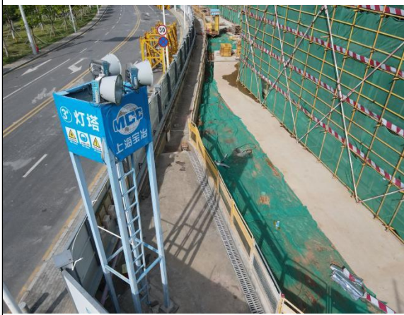
施工围挡与基坑顶部排水沟运行情况、临时覆盖防护情况
