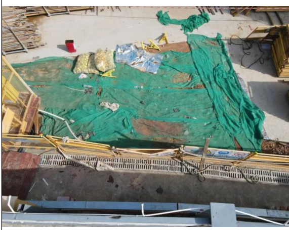
基坑顶部排水沟运行情况与临时覆盖防护情况
