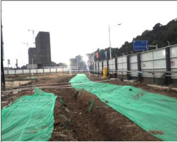
施工围挡与动态排水沟运行情况、临时覆盖防护情况
