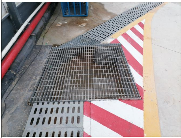
基坑顶部排水沟与单级沉砂池运行情况
