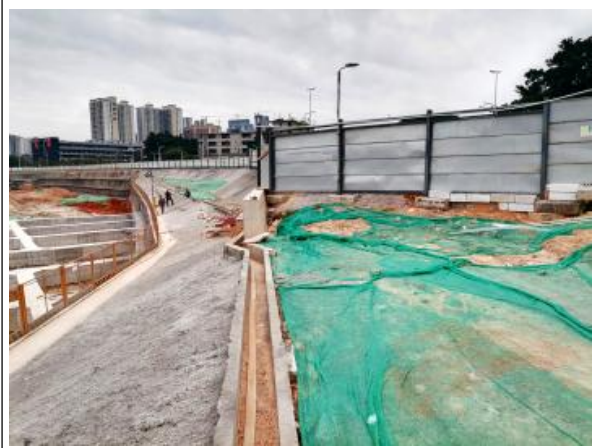
施工围挡、基坑外侧排水沟运行情况与临时覆盖防护情况
