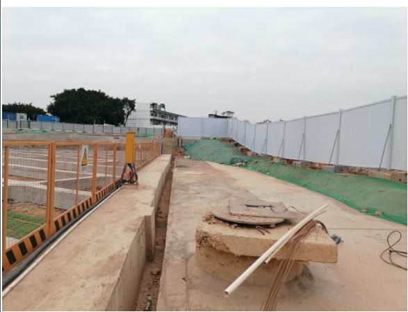
施工围挡、基坑外侧排水沟运行情况与临时覆盖防护情况
