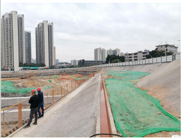
基坑外侧排水沟运行情况与临时覆盖防护情况
