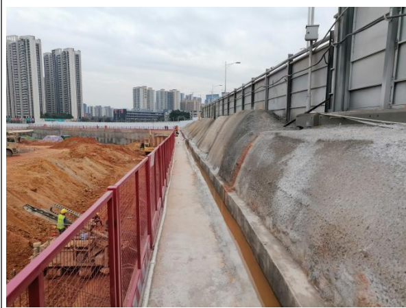
施工围挡与基坑外侧排水沟运行情况
