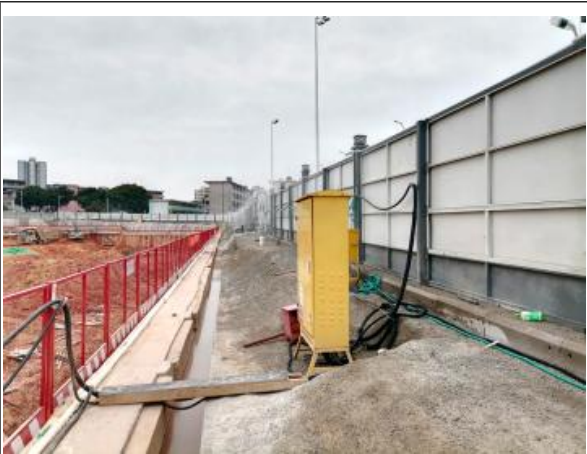
施工围挡与基坑外侧排水沟运行情况
