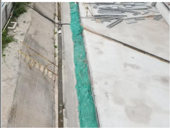
基坑外侧排水沟运行情况与临时覆盖防护情况
