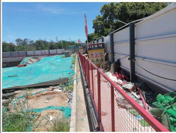
施工围挡、基坑顶部排水沟运行情况与临时覆盖防护情况
