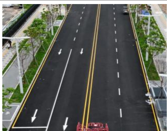
透水铺装、透水混凝土车道与道路绿化带现状
