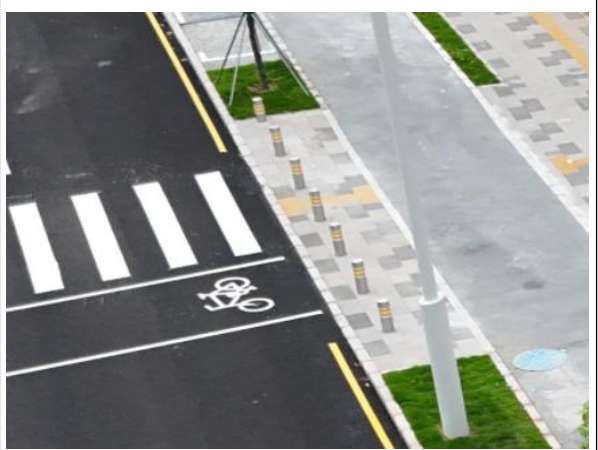
透水铺装、透水混凝土车道与道路绿化带现状
