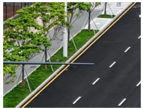
透水混凝土车道与道路绿化带现状
