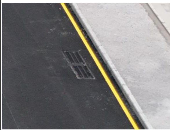
雨水管线的雨水口现状
