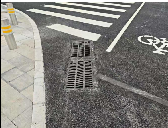
透水铺装、与雨水管线的雨水口现状
