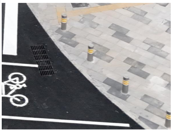
雨水管线的雨水口与透水铺装现状
