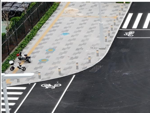
透水铺装、雨水管线的雨水口与道路绿化带现状
