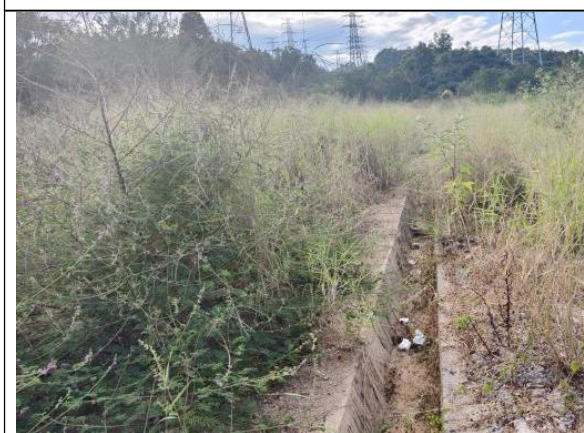
防洪达标工程的排水沟与撒播草籽覆绿现状
