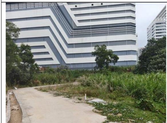
巡库路改造工程的截水沟与撒播草籽覆绿现状
