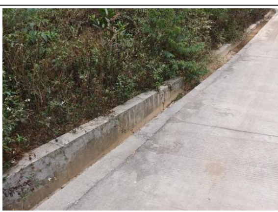
巡库路改造工程的截水沟与撒播草籽覆绿现状
