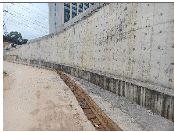
巡库路改造工程的截水沟现状
