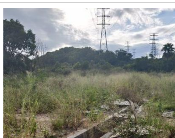
防洪达标工程的排水沟与撒播草籽覆绿现状
