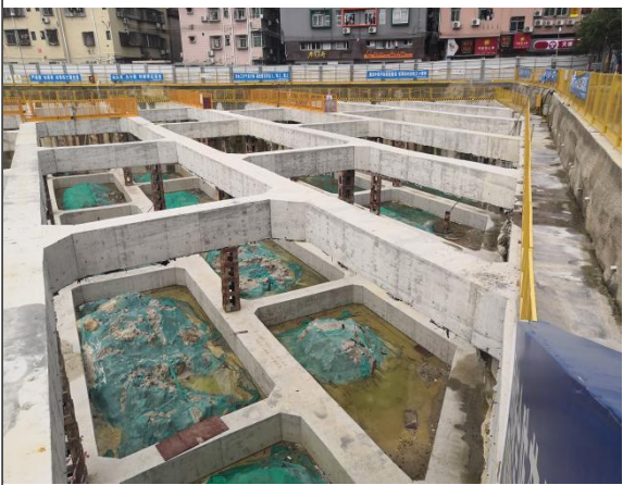
临时覆盖防护情况
