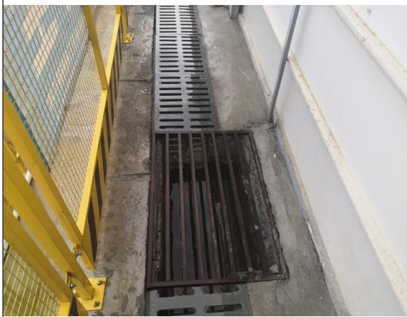
施工围挡、基坑顶部排水沟与与单级沉沙池运行情况
