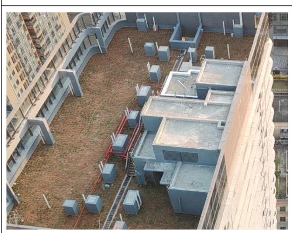
盖板排水沟与绿化工程现状
