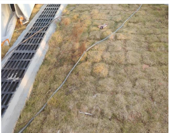
盖板排水沟与绿化工程现状
