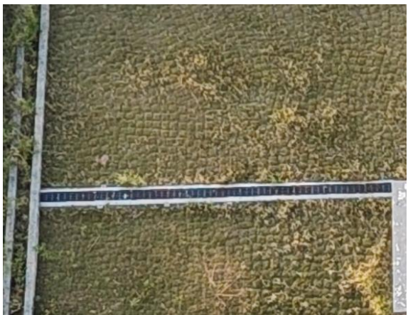
盖板排水沟与绿化工程现状现状
