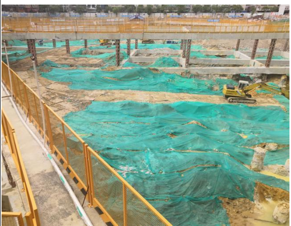
临时覆盖防护情况
