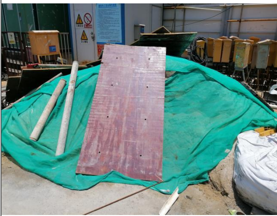
临时覆盖防护情况
