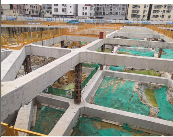
临时覆盖防护情况
