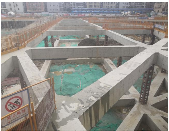
临时覆盖防护情况
