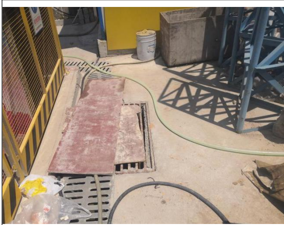
基坑顶部排水沟与单级沉沙池运行情况
