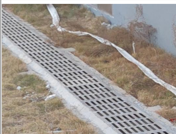
盖板排水沟与绿化工程现状
