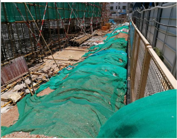
临时覆盖防护情况
