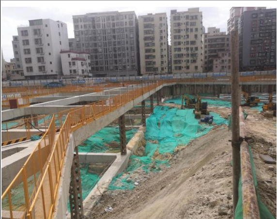
临时覆盖防护情况
