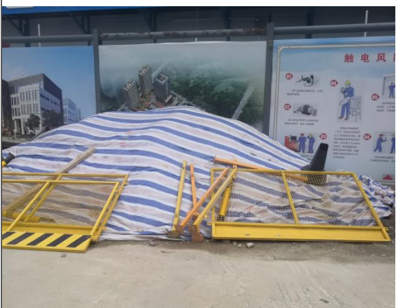
临时覆盖防护情况
