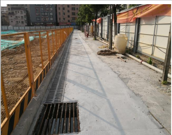
施工围挡、基坑顶部排水沟与单级沉沙池运行情况
