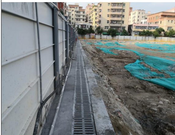
施工围挡、基坑顶部排水沟运行情况与临时覆盖防护情况
