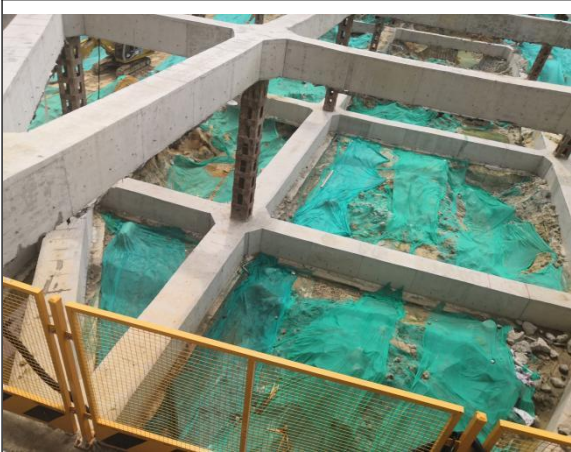
临时覆盖防护情况
