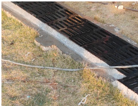
盖板排水沟与绿化工程现状
