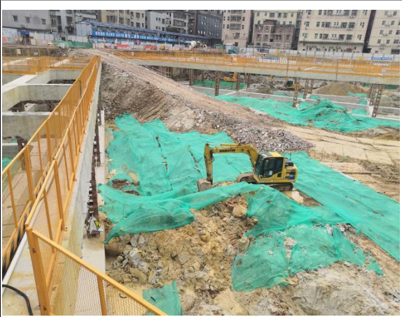
临时覆盖防护情况
