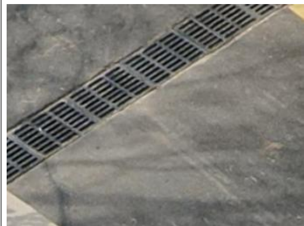
雨水管线的雨水口现状
