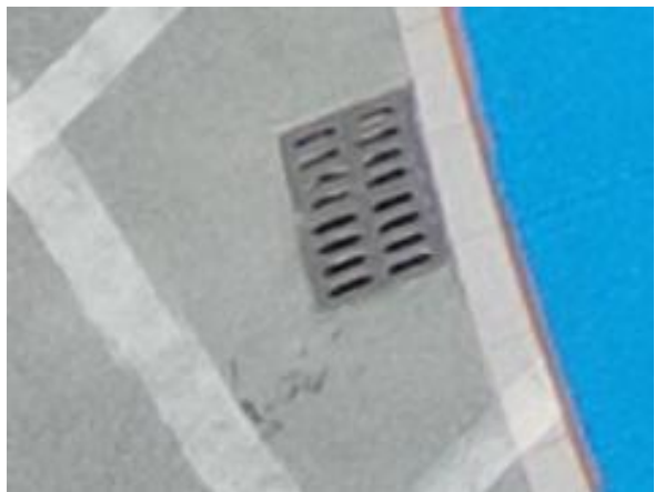
雨水管线的雨水口现状
