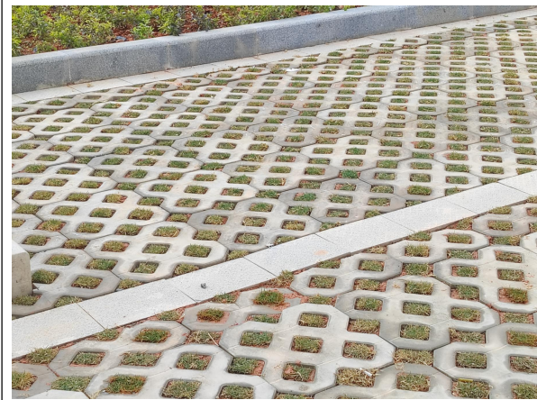
生态砖铺装现状
