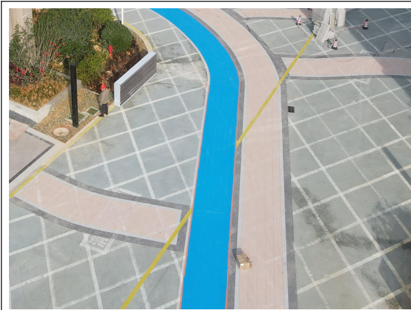
透水砖铺装现状
