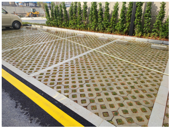
生态砖铺装现状
