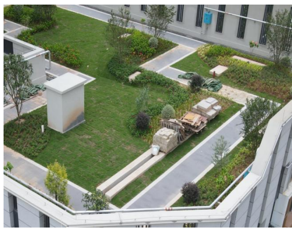
绿化工程现状
