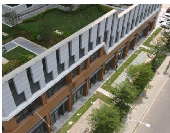
绿化工程现状
