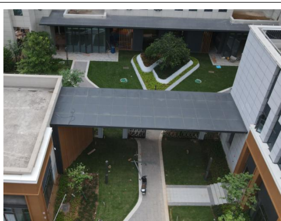
绿化工程现状
