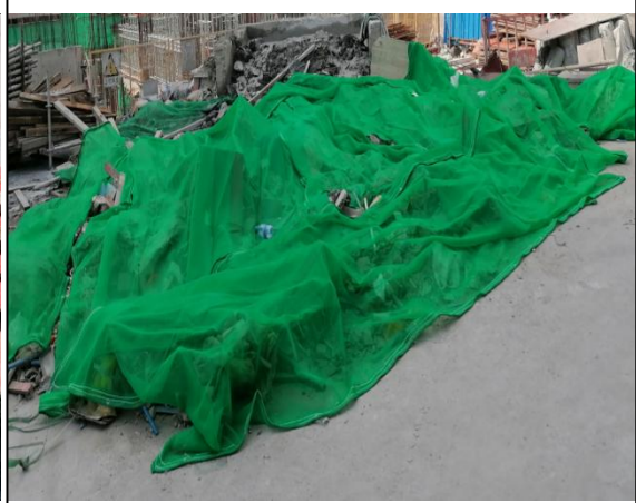
临时覆盖防护情况
