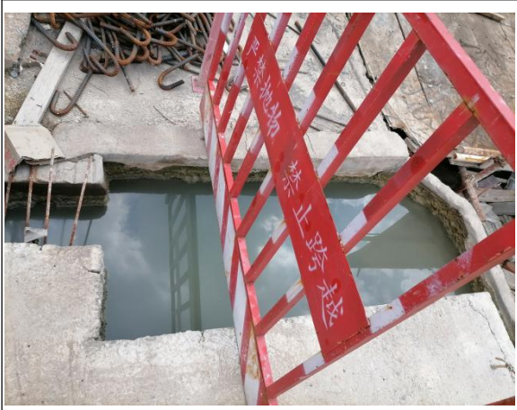
单级沉沙池运行情况
