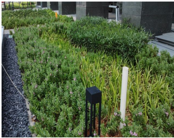
碎石铺面盖板沟与园林绿化现状
