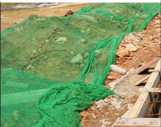
临时覆盖防护情况
