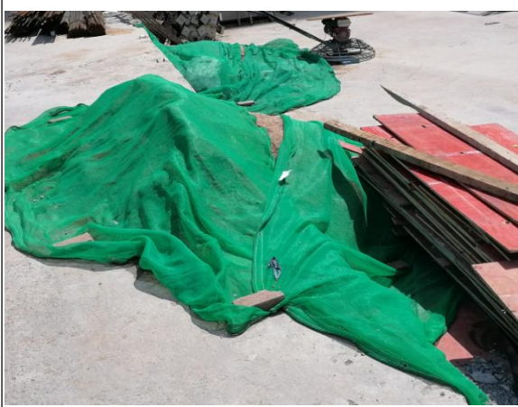
临时覆盖防护情况
