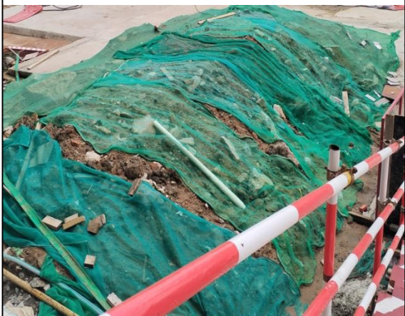
临时覆盖防护情况
