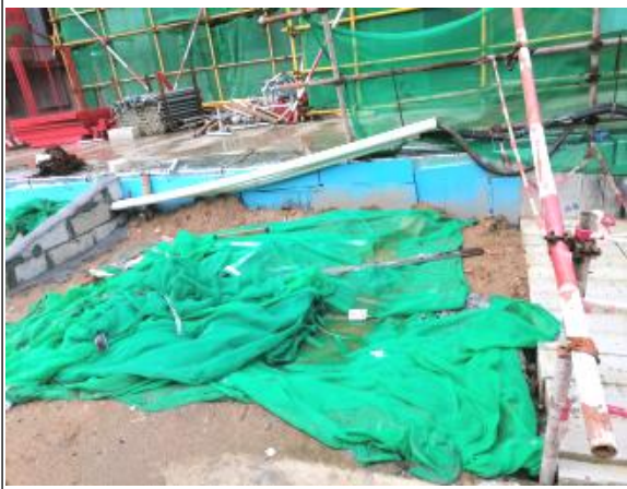
临时覆盖防护情况
