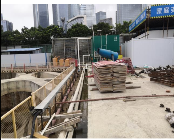
施工围墙与基坑顶部排水沟运行情况
