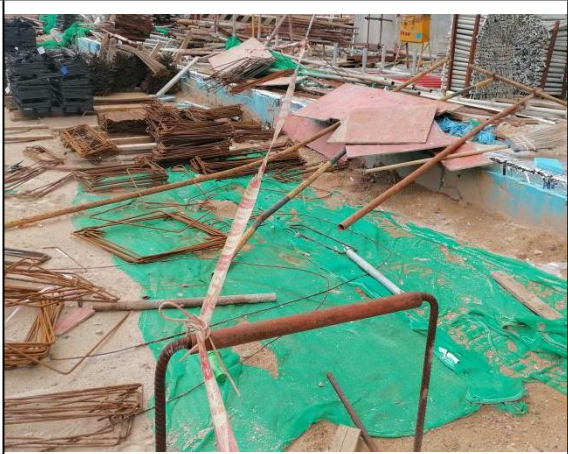
临时覆盖防护情况
