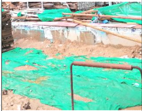
临时覆盖防护情况
