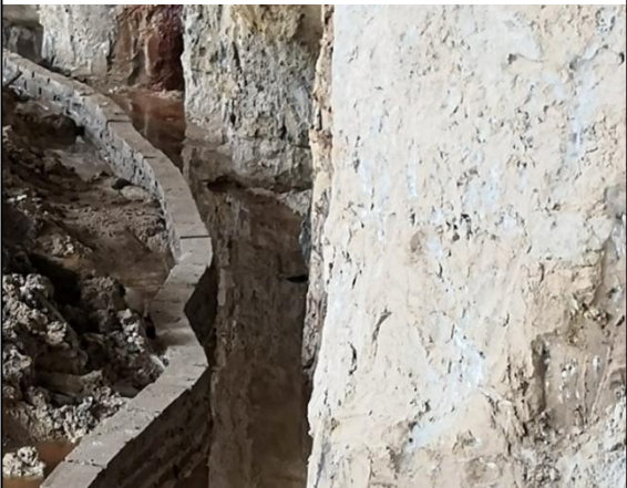
基坑底部排水沟运行情况
