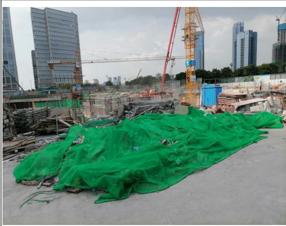
临时覆盖防护情况
