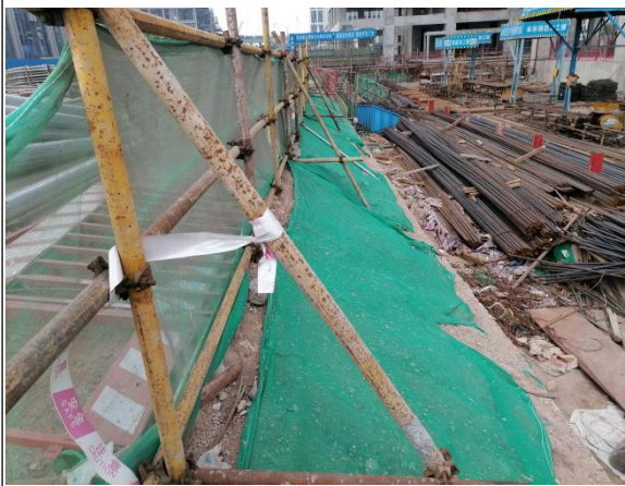
临时覆盖防护情况
