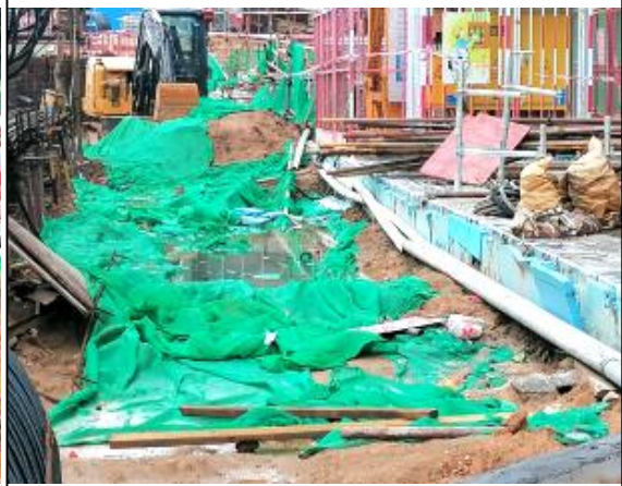
临时覆盖防护情况
