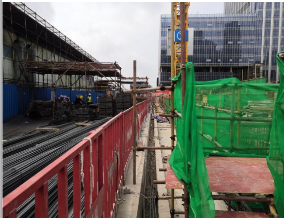
基坑顶部排水沟运行情况
