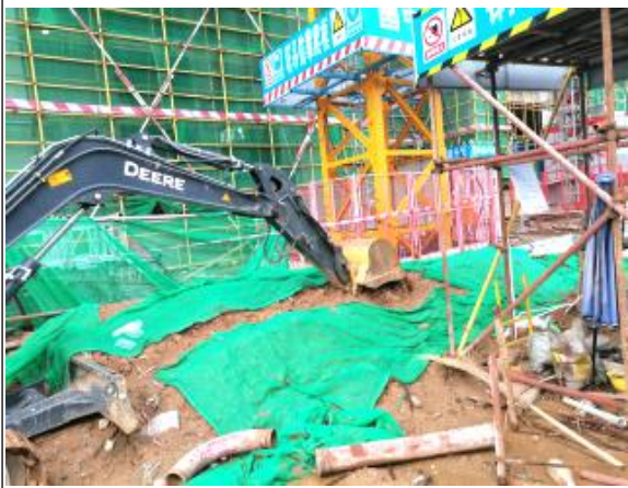
临时覆盖防护情况
