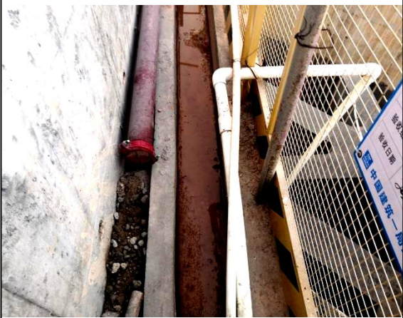
基坑顶部排水沟运行情况
