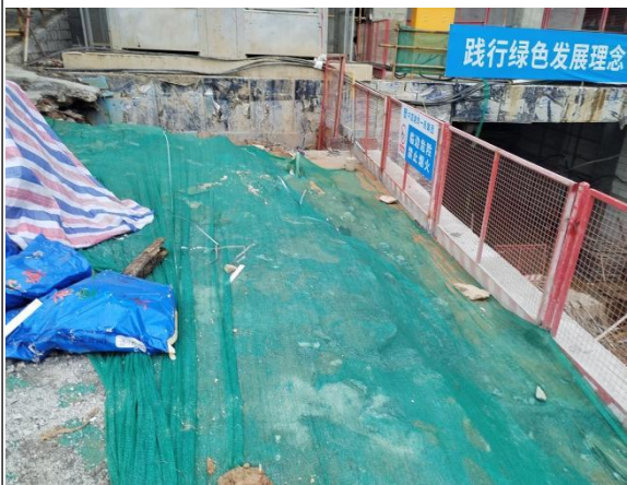
临时覆盖防护情况
