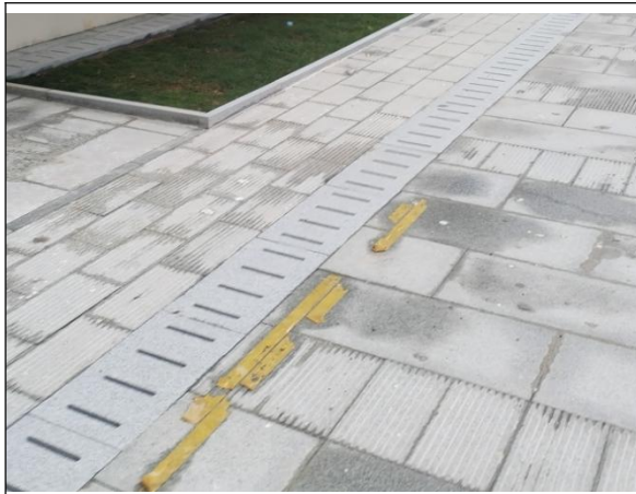
盖板排水沟现状
