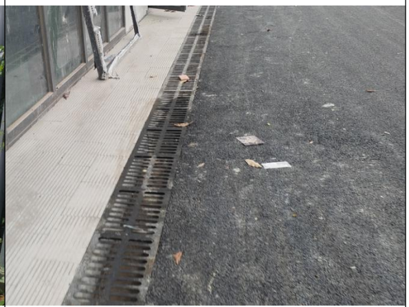
盖板排水沟现状
