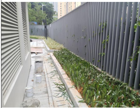
盖板排水沟现状
