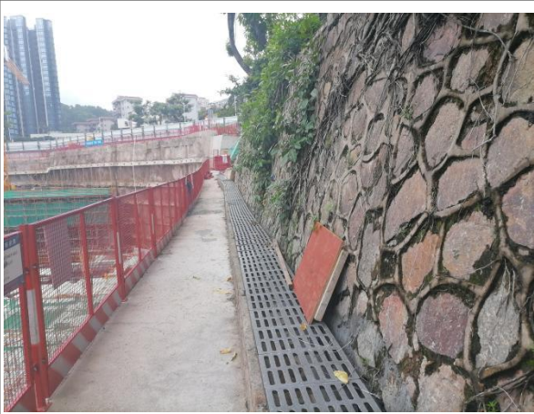
基坑顶部排水沟运行情况
