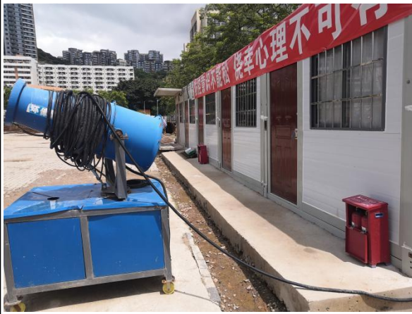
临时排水沟运行情况
