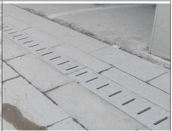
盖板排水沟现状
