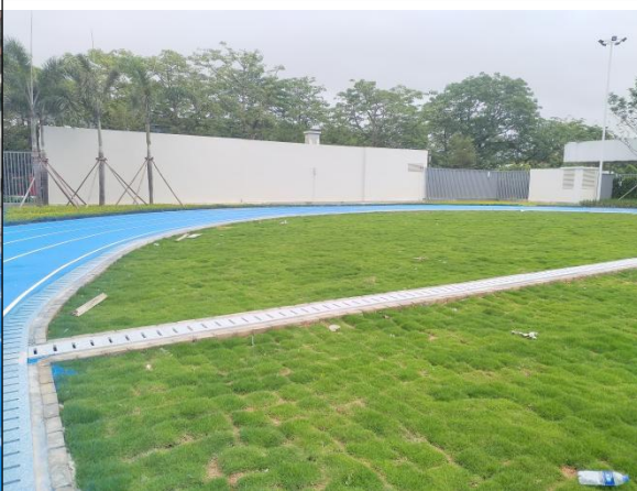
盖板排水沟现状
