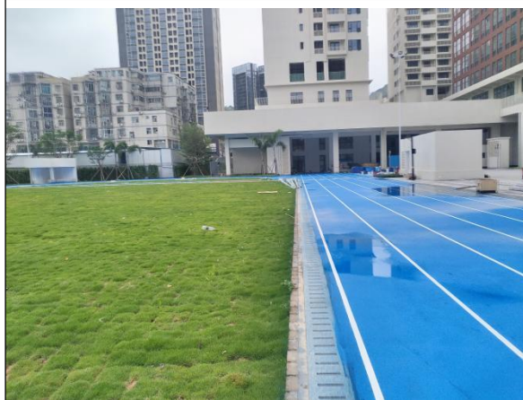
盖板排水沟现状
