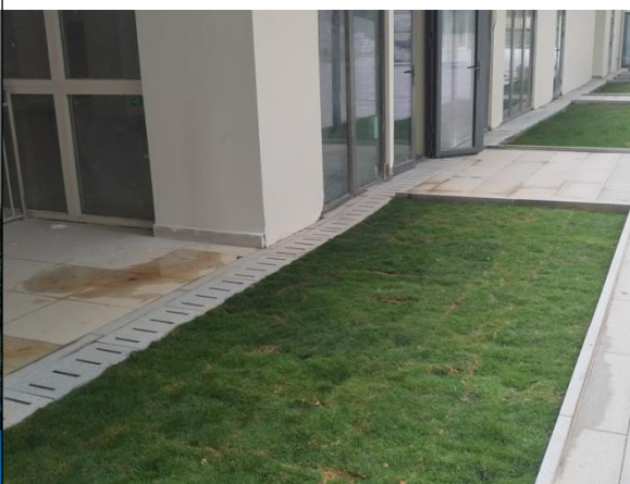
盖板排水沟现状
