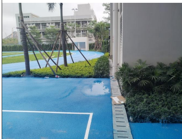
盖板排水沟现状
