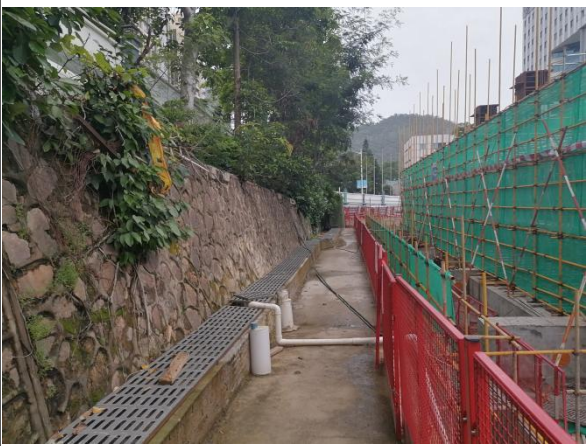
基坑顶部排水沟运行情况
