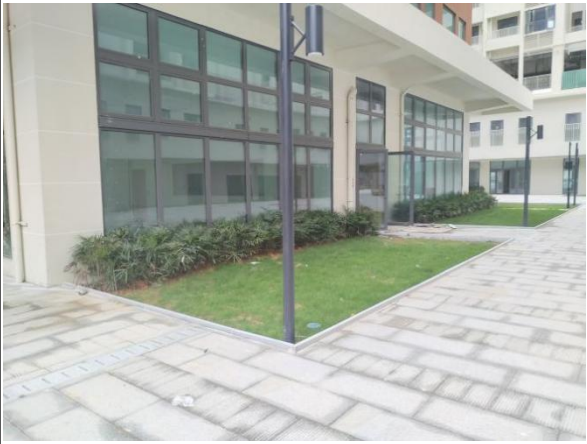
植物措施现状
