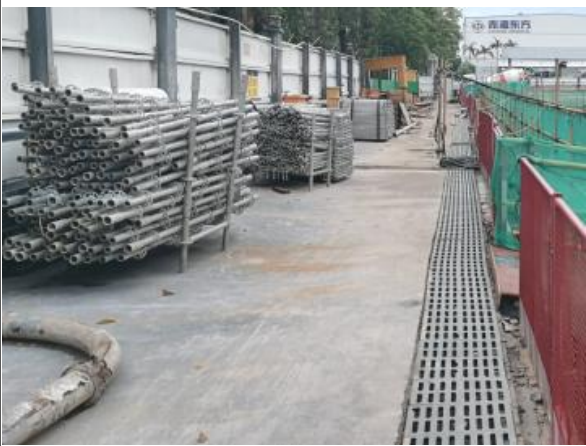
基坑顶部排水沟运行情况
