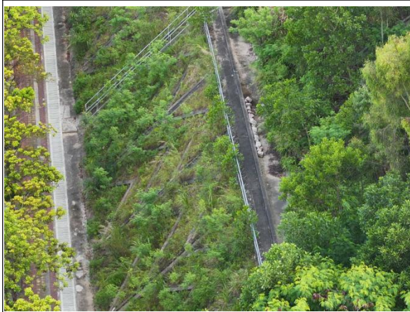
人字骨架护坡、截水沟与矩形边沟现状
