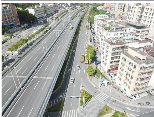
植物措施现状
