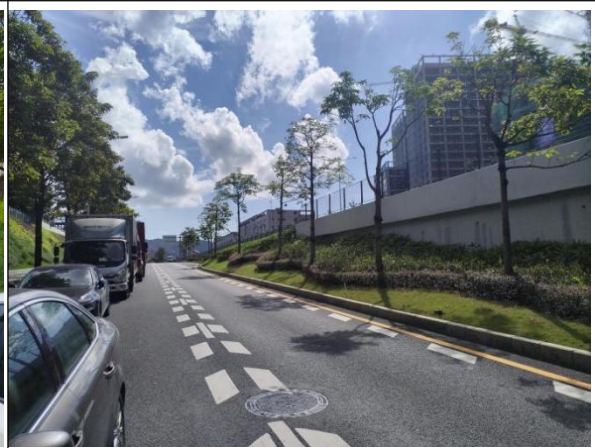
挡墙防护现状
