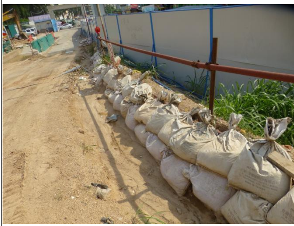
施工围挡运行情况与临时拦挡防护情况
