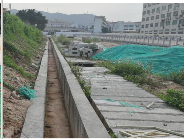
临时覆盖防护情况
