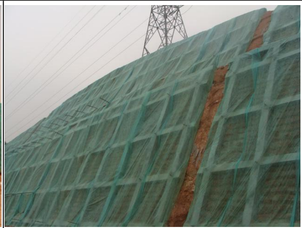
临时覆盖防护情况
