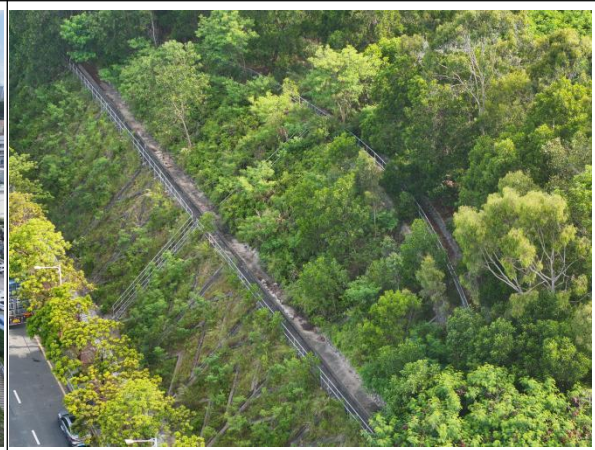
植物措施现状
