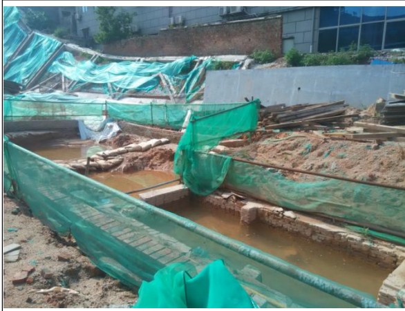
临时沉沙池运行情况与临时拦挡防护情况
