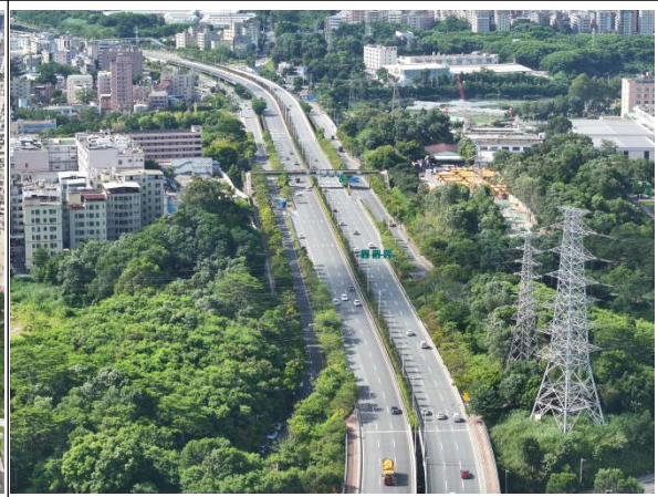
植物措施现状
