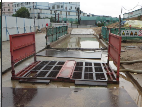
洗车设施与施工围挡运行情况
