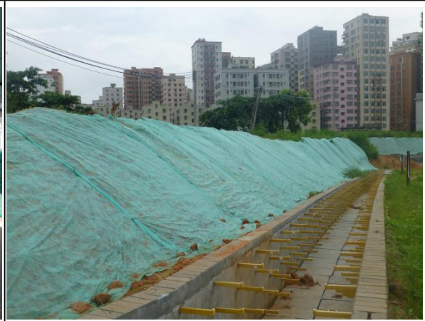
临时覆盖防护情况
