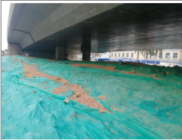
临时覆盖防护情况
