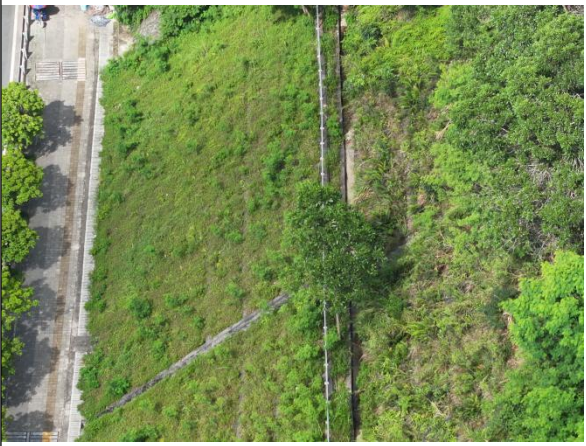
平台排水沟与矩形边沟现状
