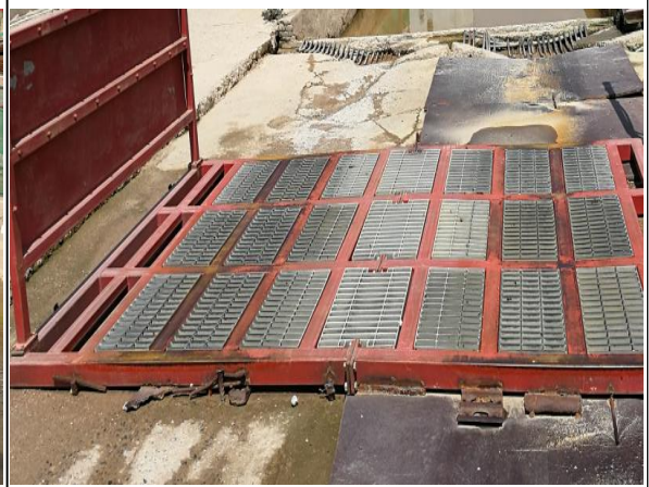
洗车设施运行情况
