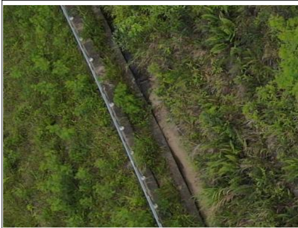
平台排水沟现状
