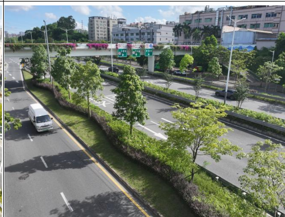
植物措施现状
