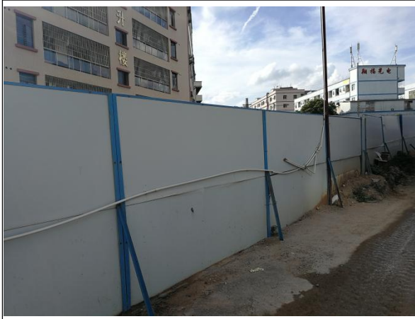
施工围挡运行情况
