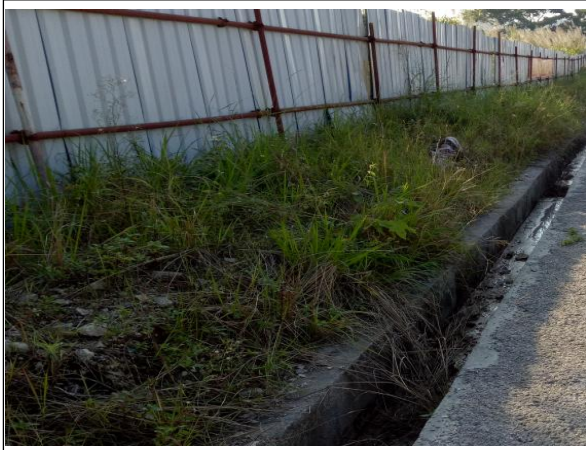
施工围挡与临时排水沟运行情况
