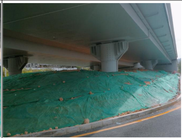
临时覆盖防护情况
