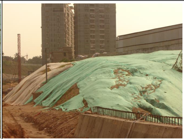
动态排水沟与临时覆盖防护情况
