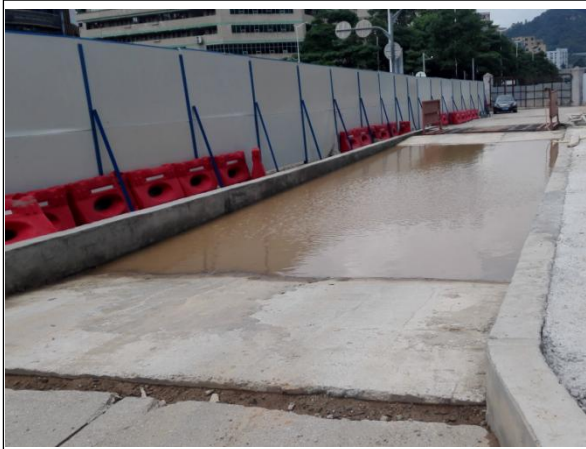
洗车设施与施工围挡运行情况
