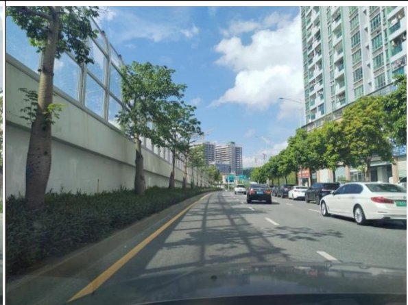
挡墙防护现状
