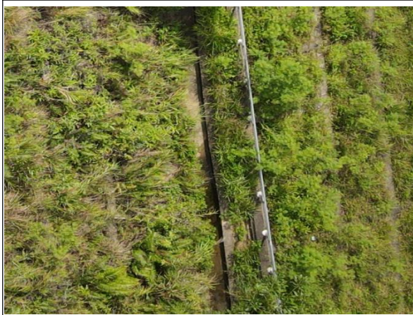
平台排水沟现状
