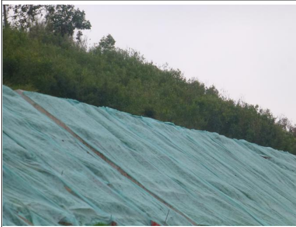
临时覆盖防护情况
