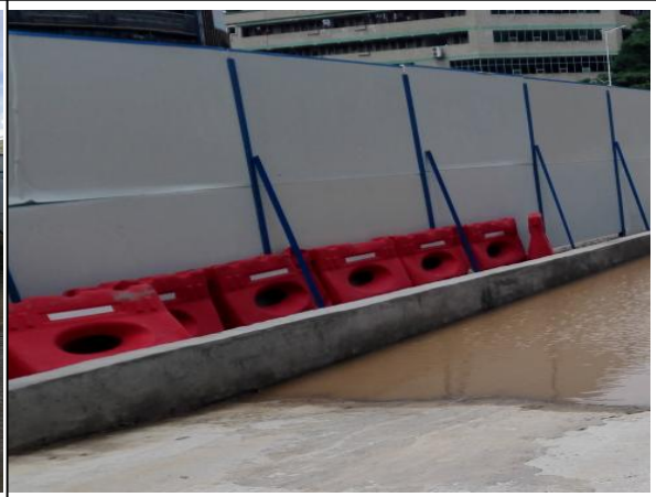
施工围挡运行情况
