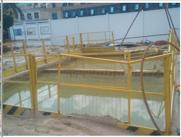
施工围挡与临时沉沙池运行情况
