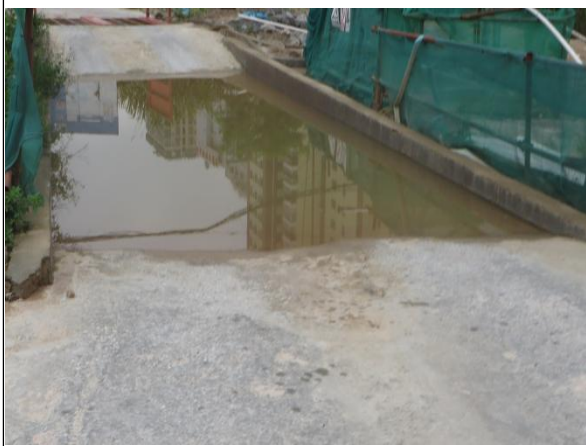
洗车设施运行情况
