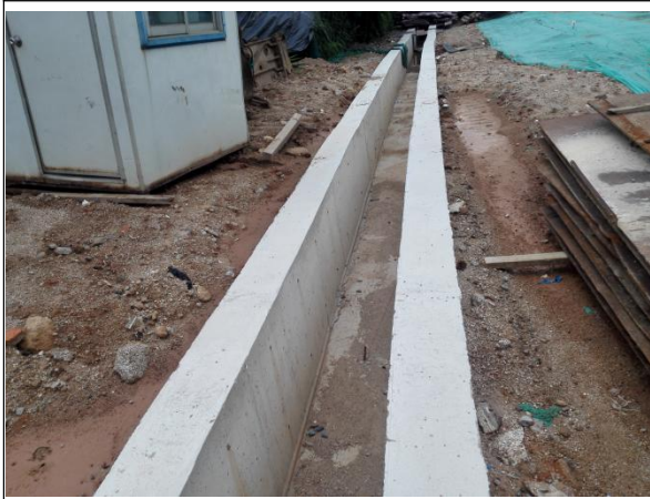
临时排水沟运行与临时覆盖防护情况
