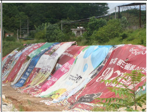
临时覆盖防护情况
