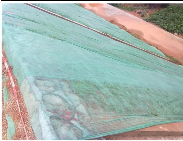
临时覆盖防护情况
