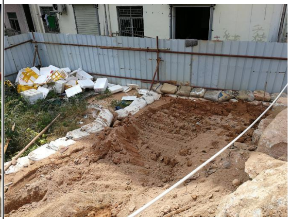
施工围挡运行情况与临时拦挡防护情况
