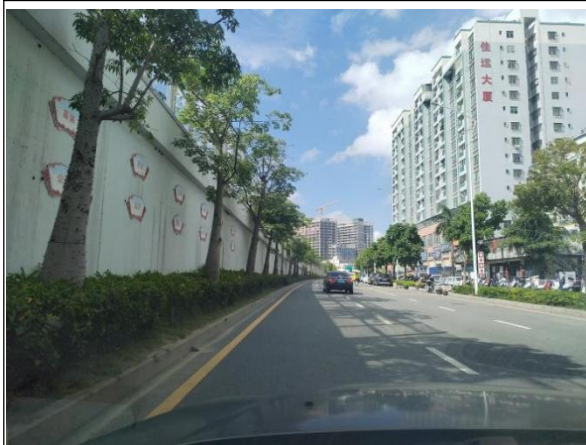
挡墙防护现状
