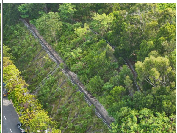
人字骨架护坡、截水沟与平台排水沟现状
