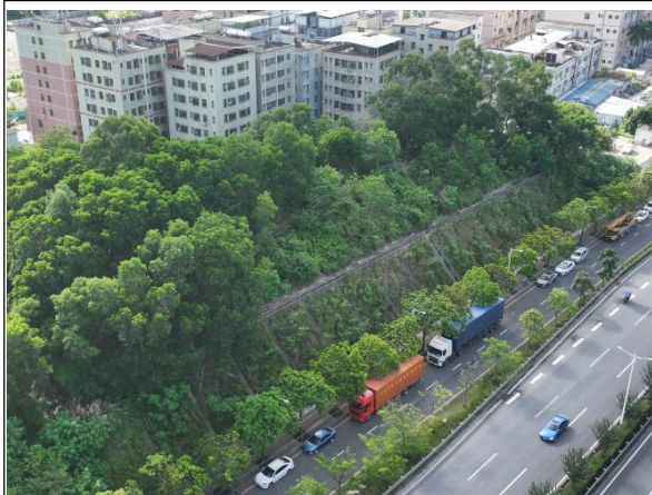
人字骨架护坡现状
