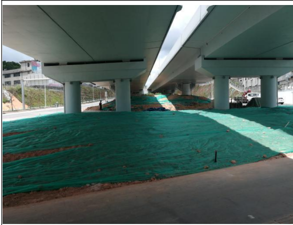
临时覆盖防护情况
