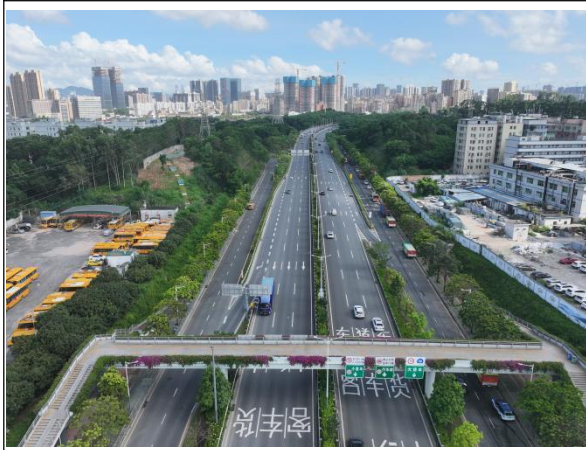
植物措施现状
