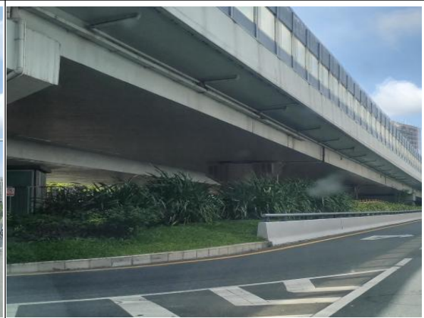
植物措施现状
