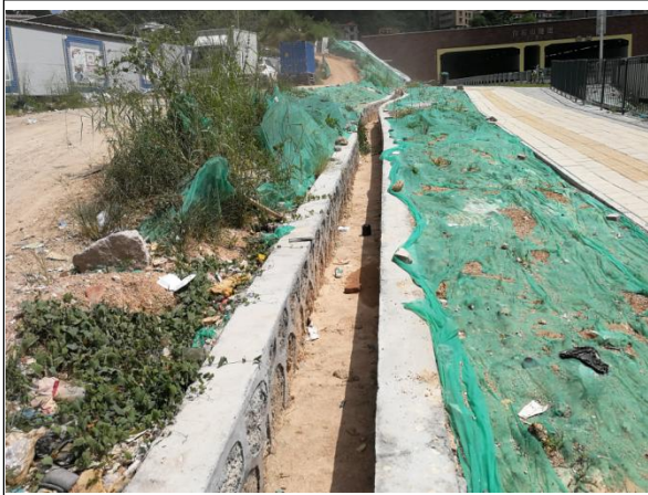
临时覆盖防护情况
