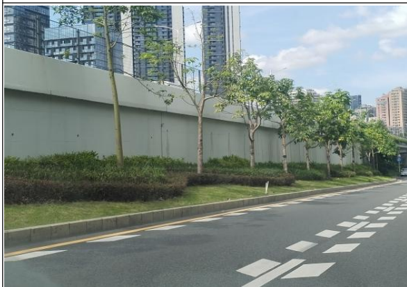
挡墙防护现状
