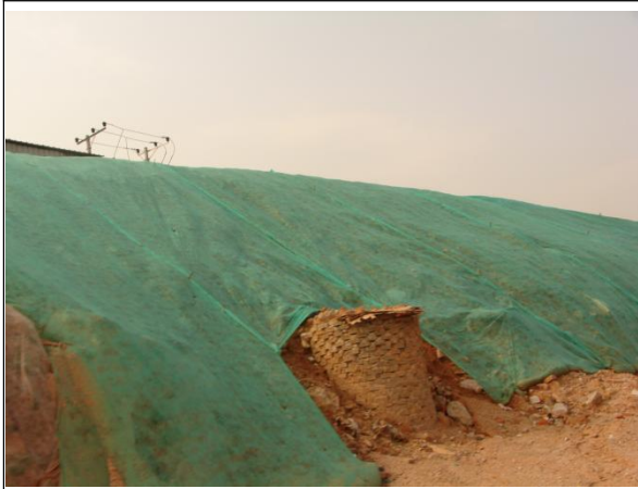
临时覆盖防护情况
