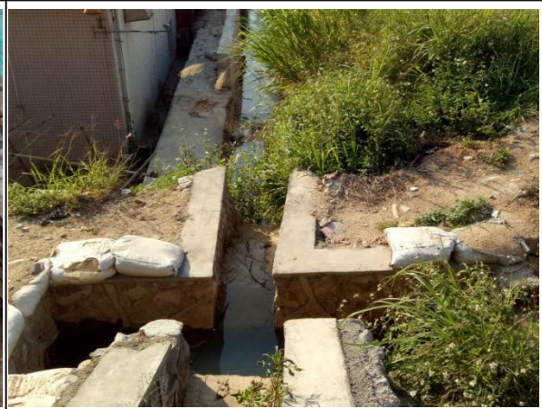
临时排水沉沙运行情况与临时拦挡防护情况
