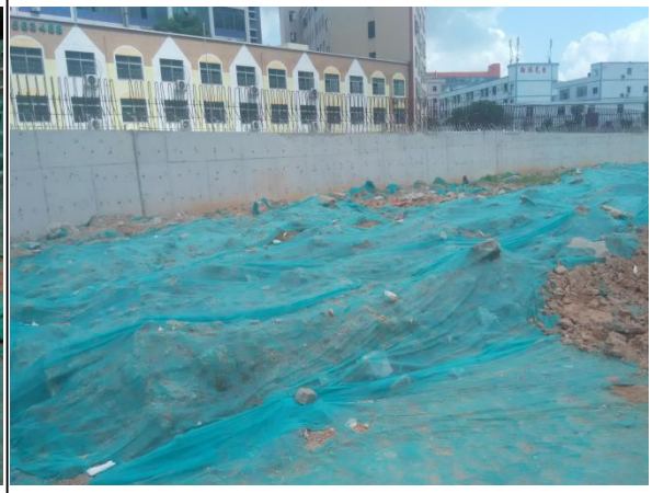
临时覆盖防护情况
