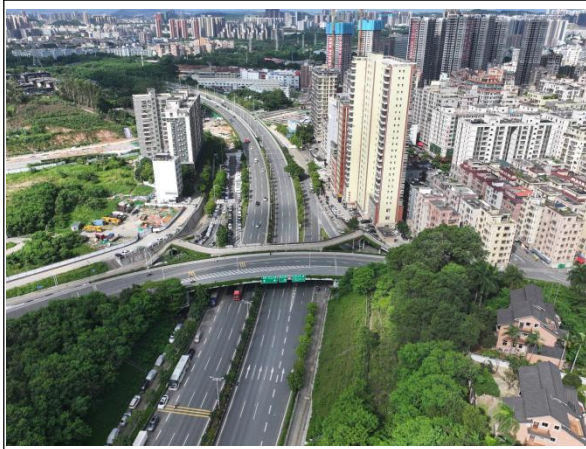
植物措施现状
