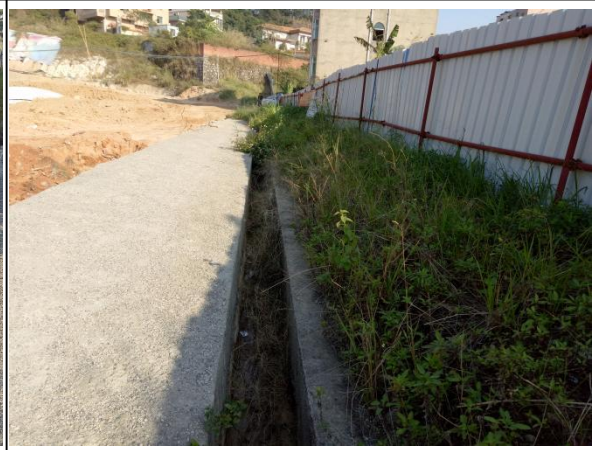
施工围挡与临时排水沟运行情况
