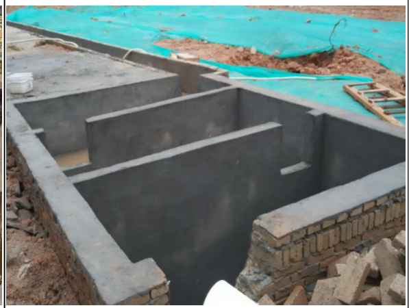
临时排水沉沙设施运行情况与临时覆盖防护情况
