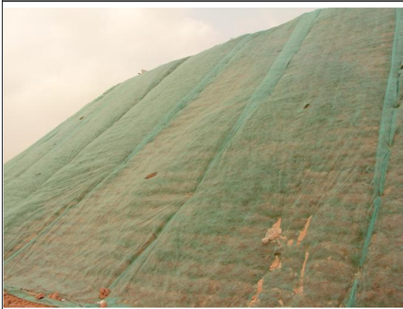
临时覆盖防护情况
