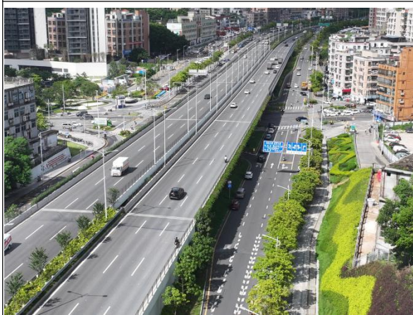
植物措施现状
