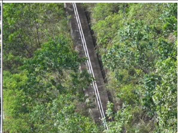
平台排水沟现状
