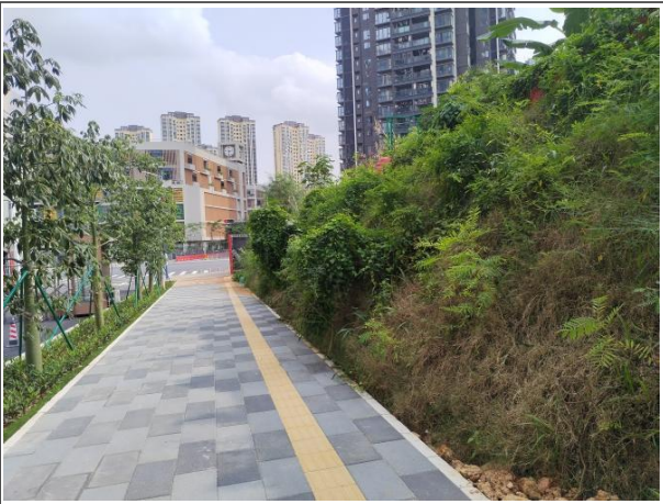
植草护坡与透水砖铺装现状
