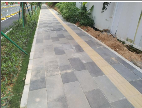
透水砖铺装现状
