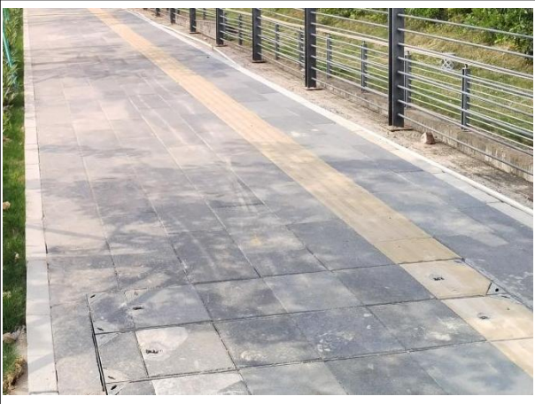
透水砖铺装现状
