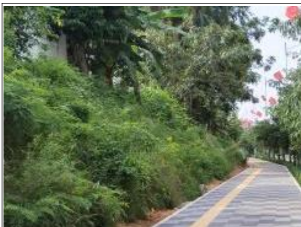
植草护坡与透水砖铺装现状
