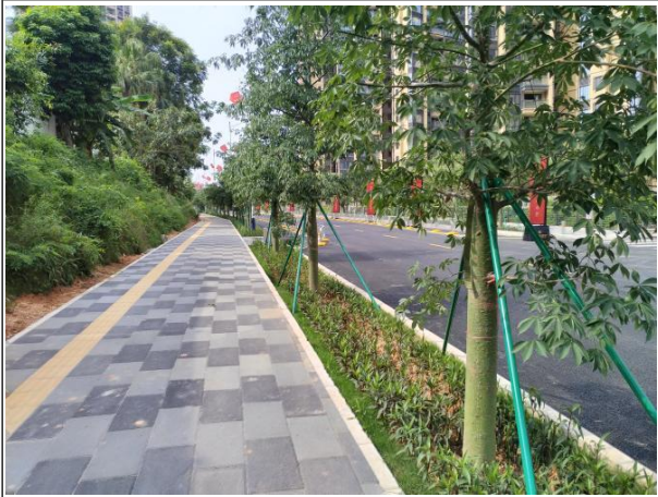
透水砖铺装现状
