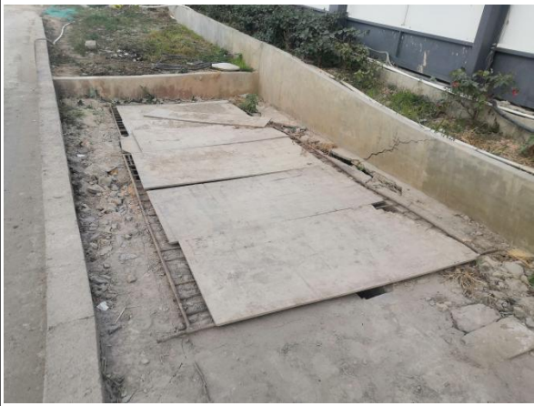
施工围挡与三级沉沙池运行情况
