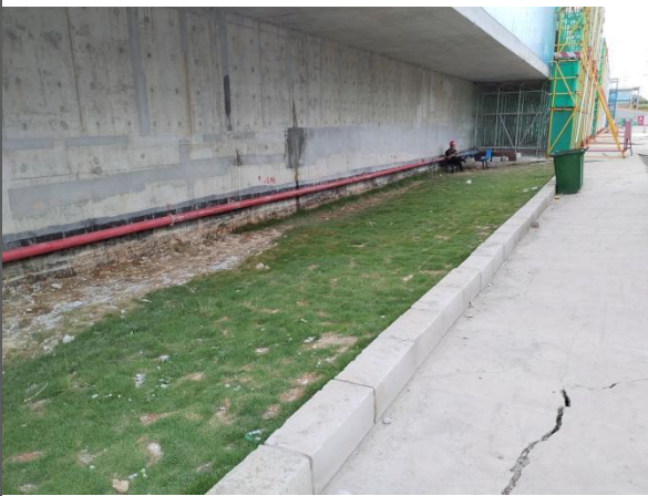
临时性绿化防护情况
