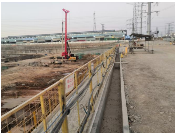
基坑顶部排水沟运行情况
