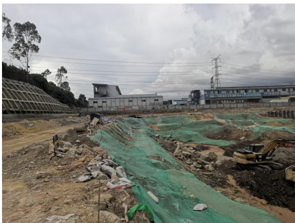
临时覆盖防护情况
