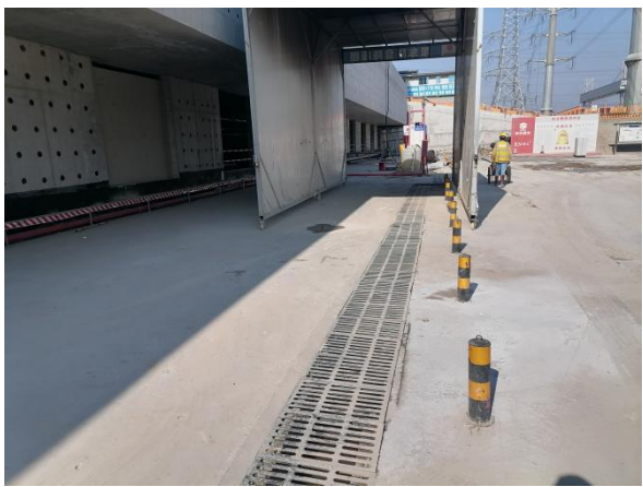
基坑顶部排水沟运行情况
