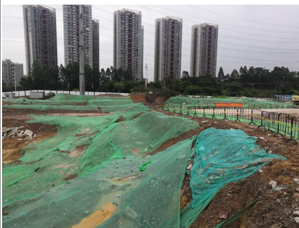
临时覆盖防护情况
