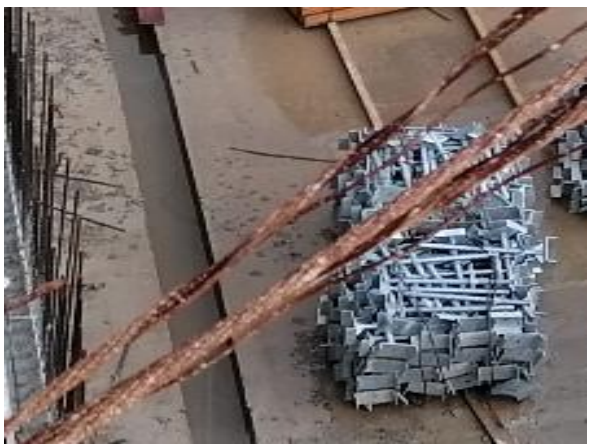
基坑底部排水沟运行情况
