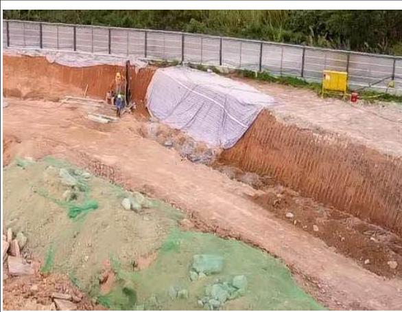
施工围挡与临时覆盖防护情况
