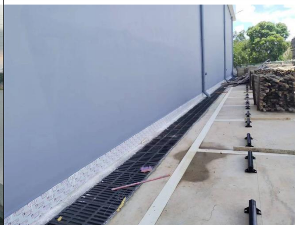
盖板排水沟现状
