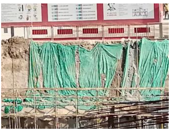
临时覆盖防护情况
