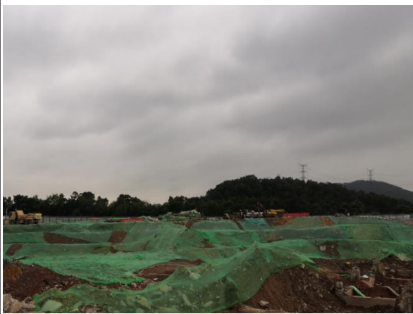
临时覆盖防护情况
