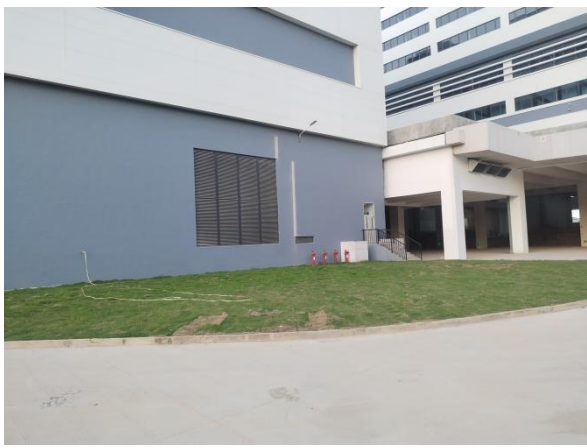
临时性绿化防护情况
