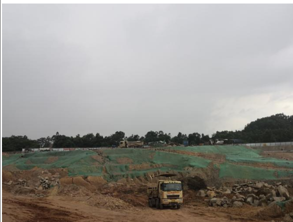
临时覆盖防护情况
