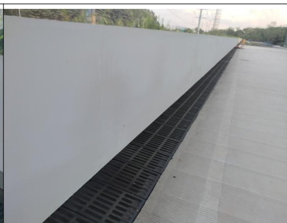
盖板排水沟现状
