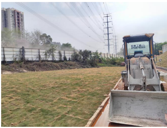
临时性绿化防护情况
