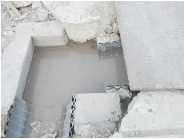
临时沉沙池运行情况
