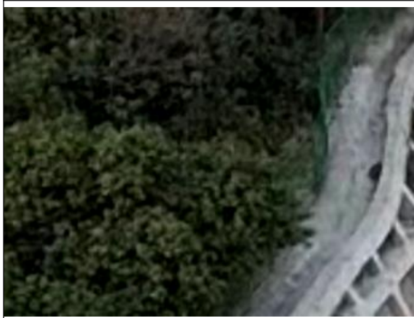
坡顶截水沟运行情况
