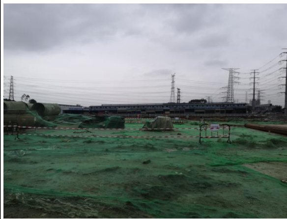
临时覆盖防护情况
