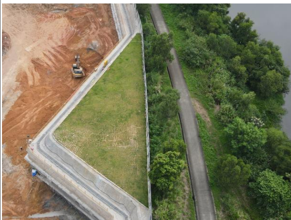
临时性绿化防护情况
