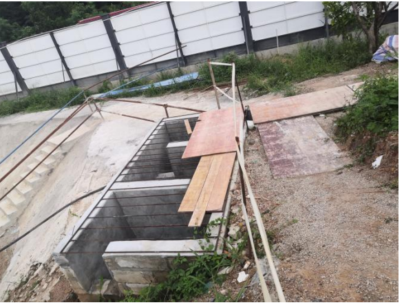
施工围挡与三级沉沙池运行情况
