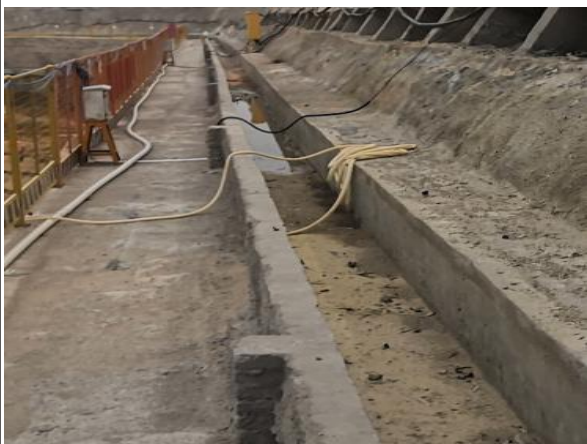
基坑顶部排水沟运行情况
