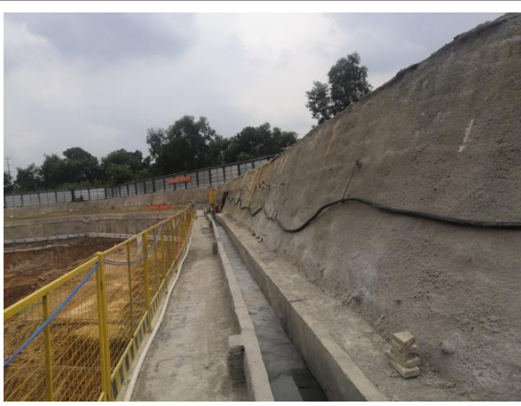
基坑顶部排水沟运行情况
