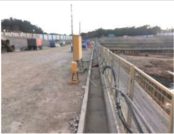
基坑顶部排水沟运行情况
