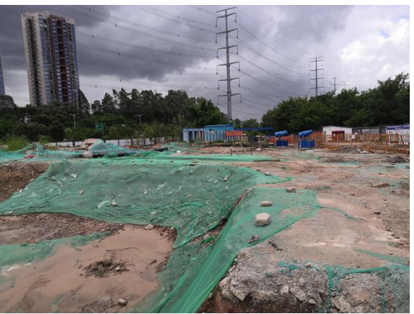
临时覆盖防护情况
