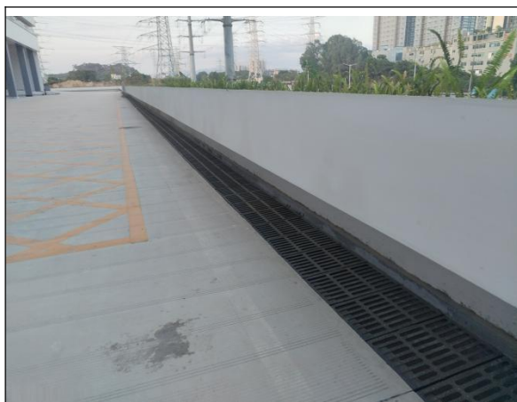
盖板排水沟现状
