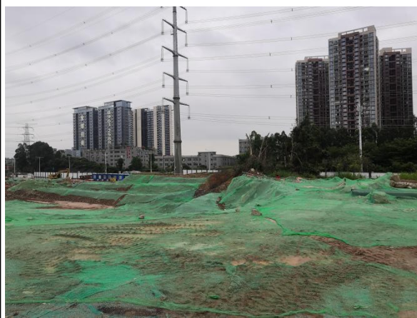
临时覆盖防护情况
