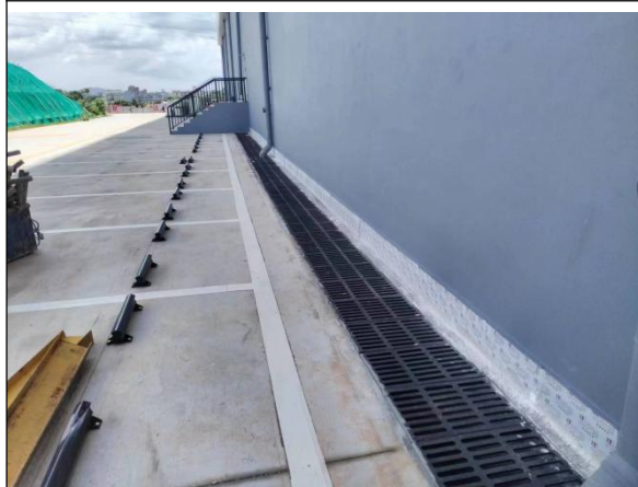
盖板排水沟现状
