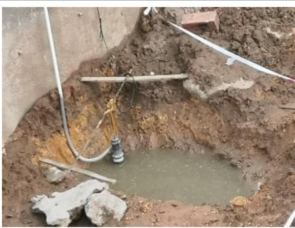
土质集水井运行情况
