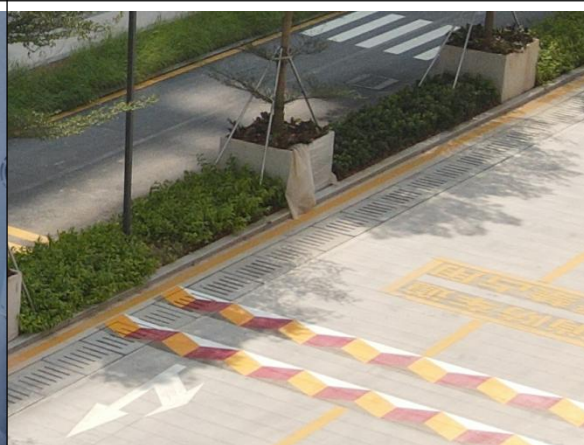
盖板排水沟现状
