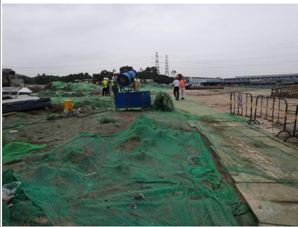
临时覆盖防护情况
