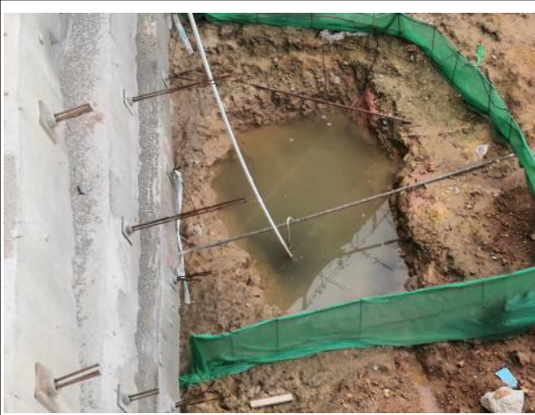
土质集水井运行情况
