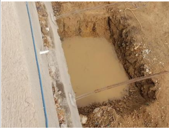
土质集水井运行情况
