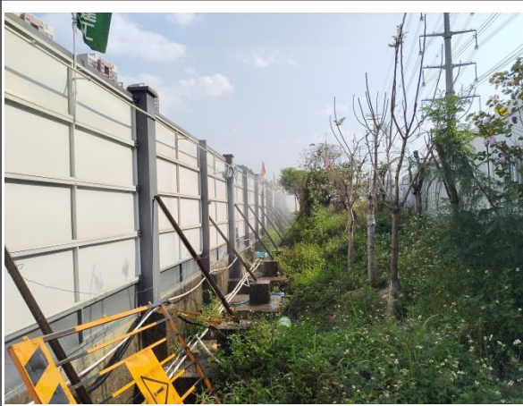
施工围挡与临时性绿化防护情况
