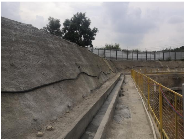
基坑顶部排水沟运行情况
