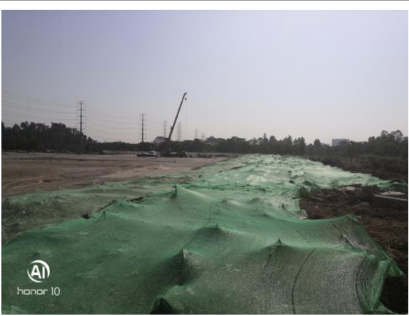
临时覆盖防护情况
