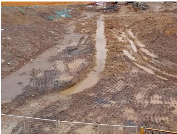
土质排水沟运行情况
