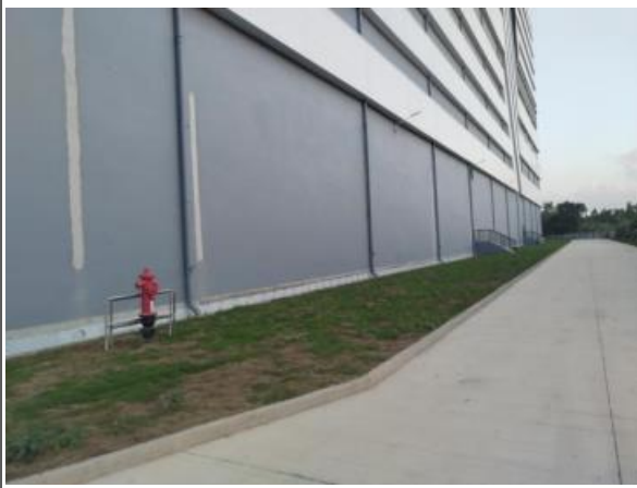
临时性绿化防护情况
