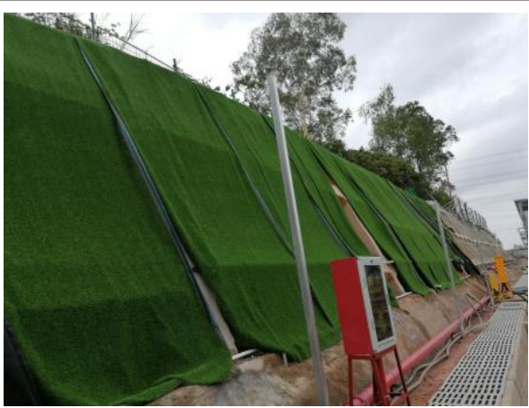
基坑顶部排水沟运行与临时覆盖防护情况
