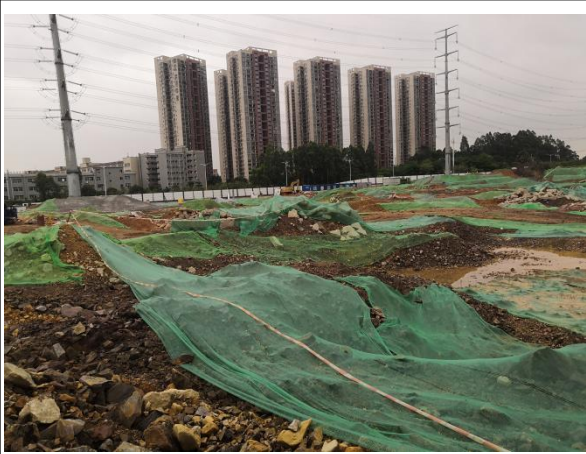
临时覆盖防护情况
