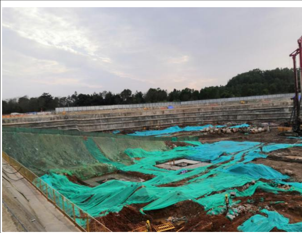
临时覆盖防护情况
