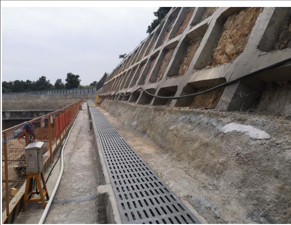
基坑顶部排水沟与在建边坡防护运行情况
