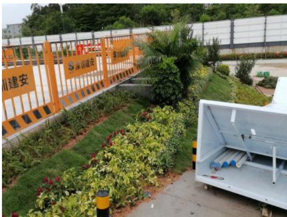
临时性绿化防护情况
