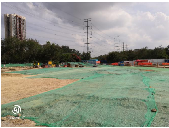
临时覆盖防护情况
