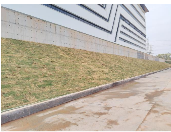
临时性绿化防护情况
