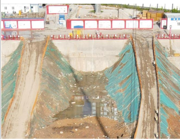
临时覆盖防护情况
