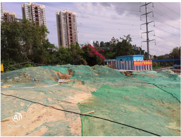
临时覆盖防护情况
