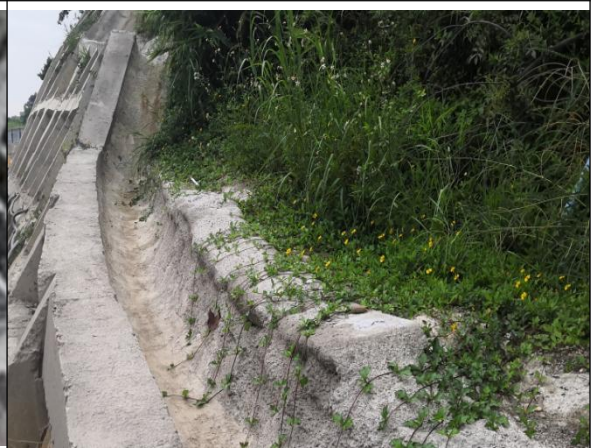
坡顶截水沟运行情况
