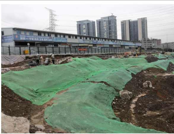
临时覆盖防护情况
