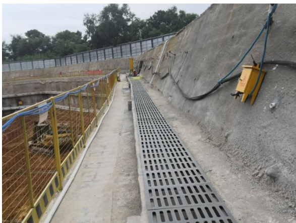
基坑顶部排水沟运行情况
