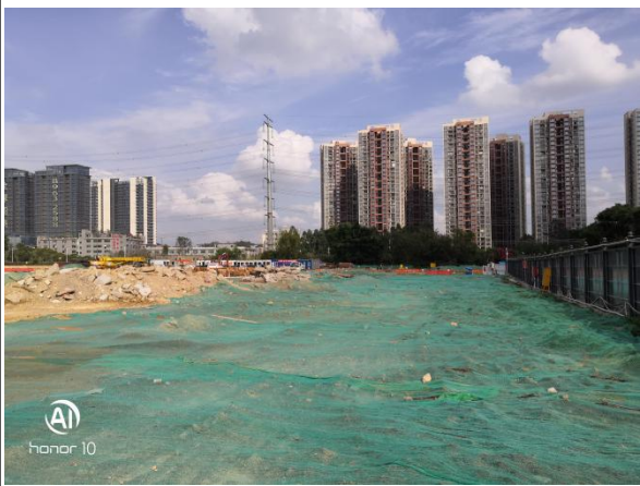
临时覆盖防护情况
