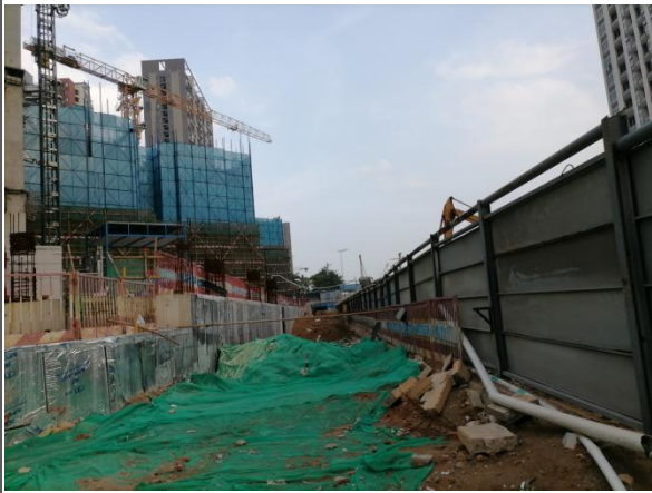
施工围挡运行与临时覆盖防护情况
