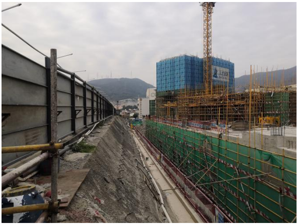
施工围挡与基坑顶排水沟运行情况
