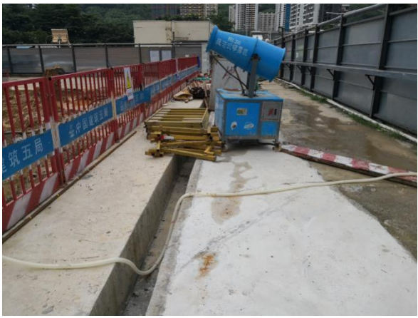
施工围挡与基坑顶排水沟运行情况
