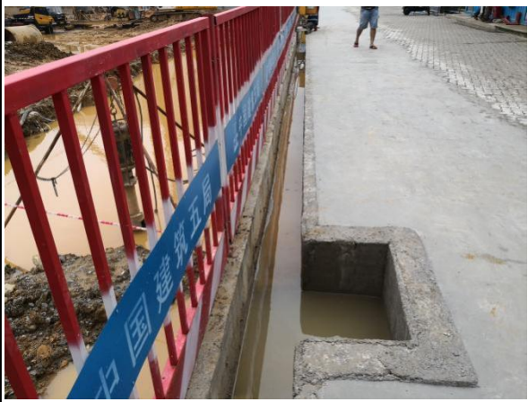
基坑顶排水沟与单级沉沙池运行情况
