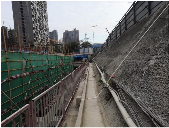
施工围挡与基坑顶排水沟运行情况
