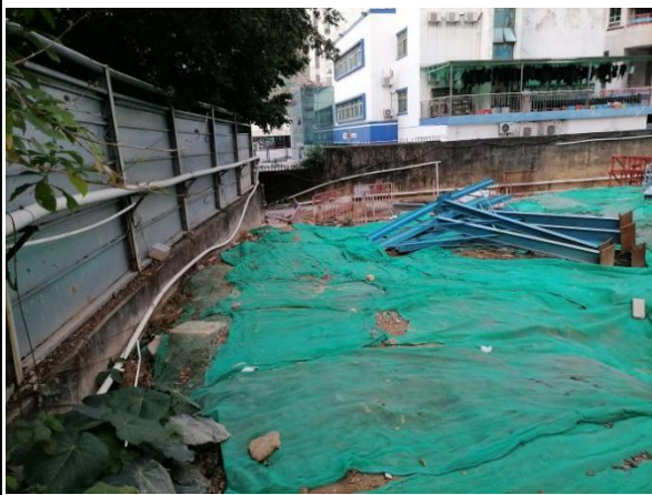
施工围挡运行与临时覆盖防护情况
