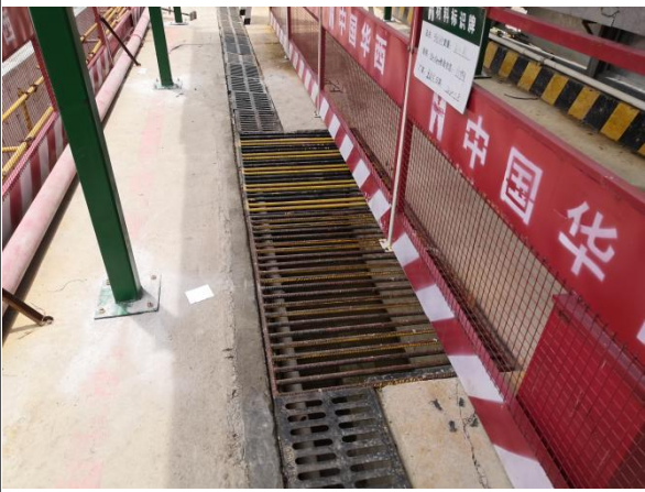
基坑顶临时排水沟与单级沉沙池运行情况
