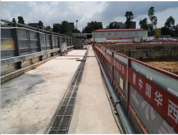
施工围挡与基坑顶临时排水沟运行情况
