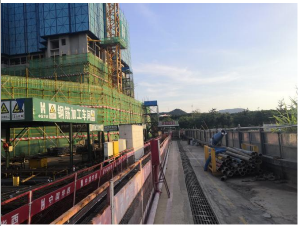
施工围挡与基坑顶临时排水沟运行情况
