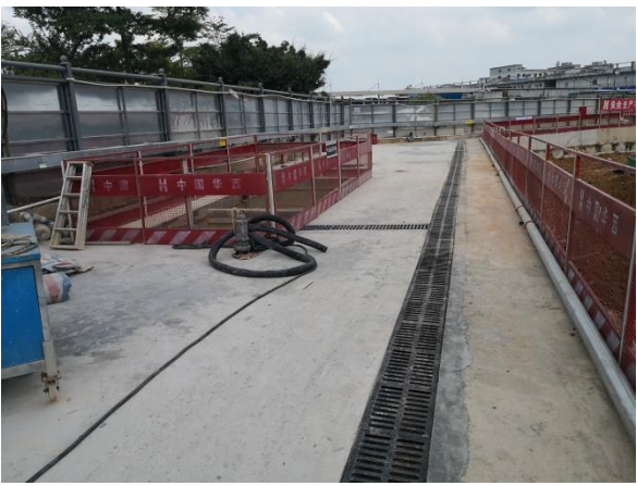
施工围挡、三级沉沙池与基坑顶临时排水沟运行情况
