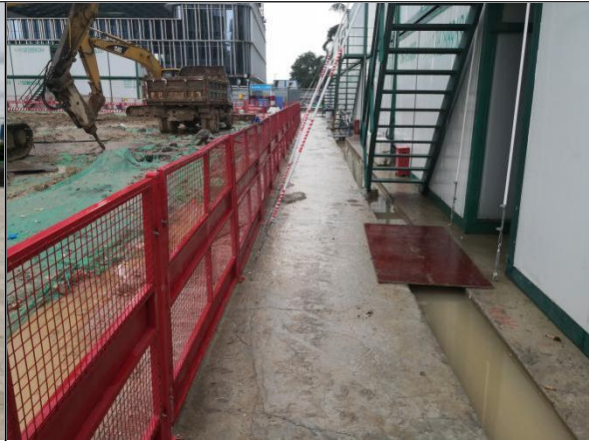
基坑顶部排水沟运行情况
