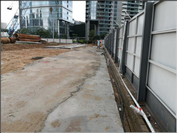
施工围挡与其余区域临时排水沟运行情况
