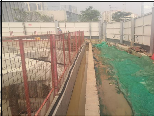
施工围挡、基坑顶部排水沟与临时覆盖运行情况
