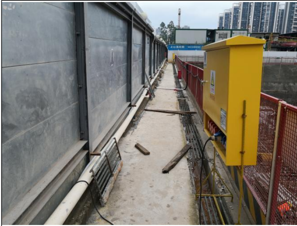
基坑顶部临时排水沟与施工围挡措施
