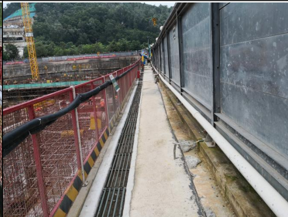
基坑顶部临时排水沟与施工围挡措施
