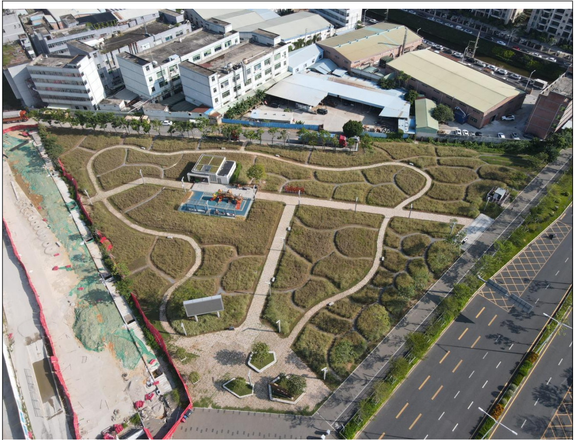
项目区航拍全景照
