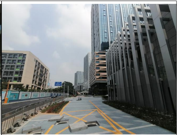
项目区西侧永久性绿化现状
