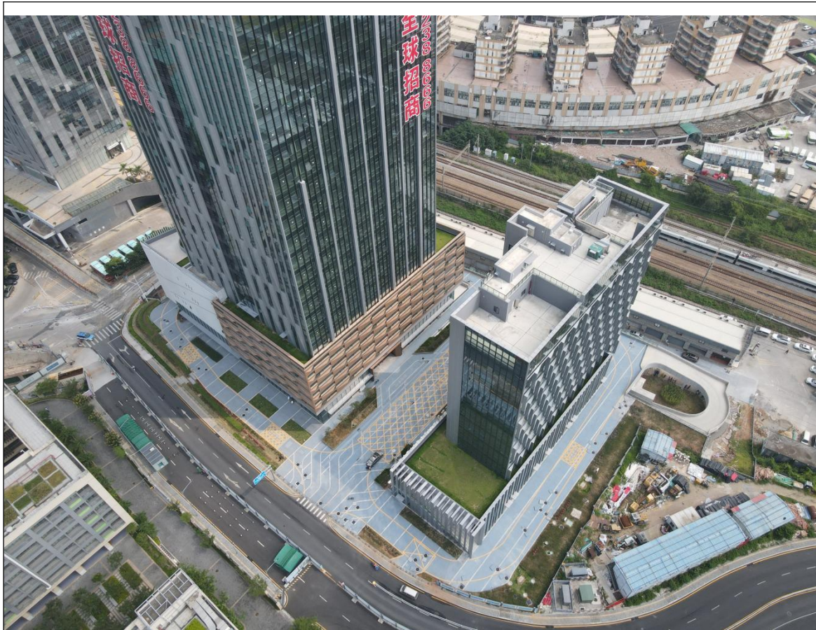
项目区航拍全景照
