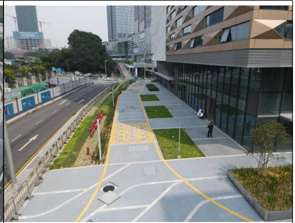
项目区西侧永久性绿化现状
