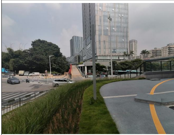
项目区西侧永久性绿化现状
