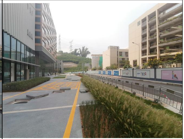
项目区西侧永久性绿化现状
