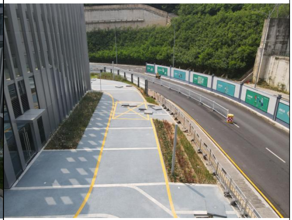
项目区西侧永久性绿化现状
