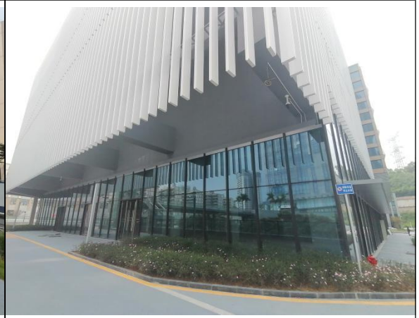
项目区西侧永久性绿化现状
