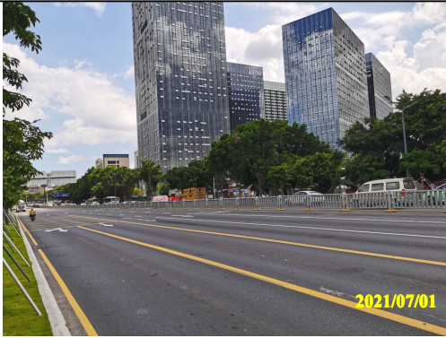
沙河西路桩号 SK0+140 由北向南
