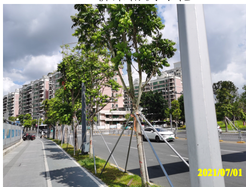
龙珠一路桩号 K0+140 北侧绿化
